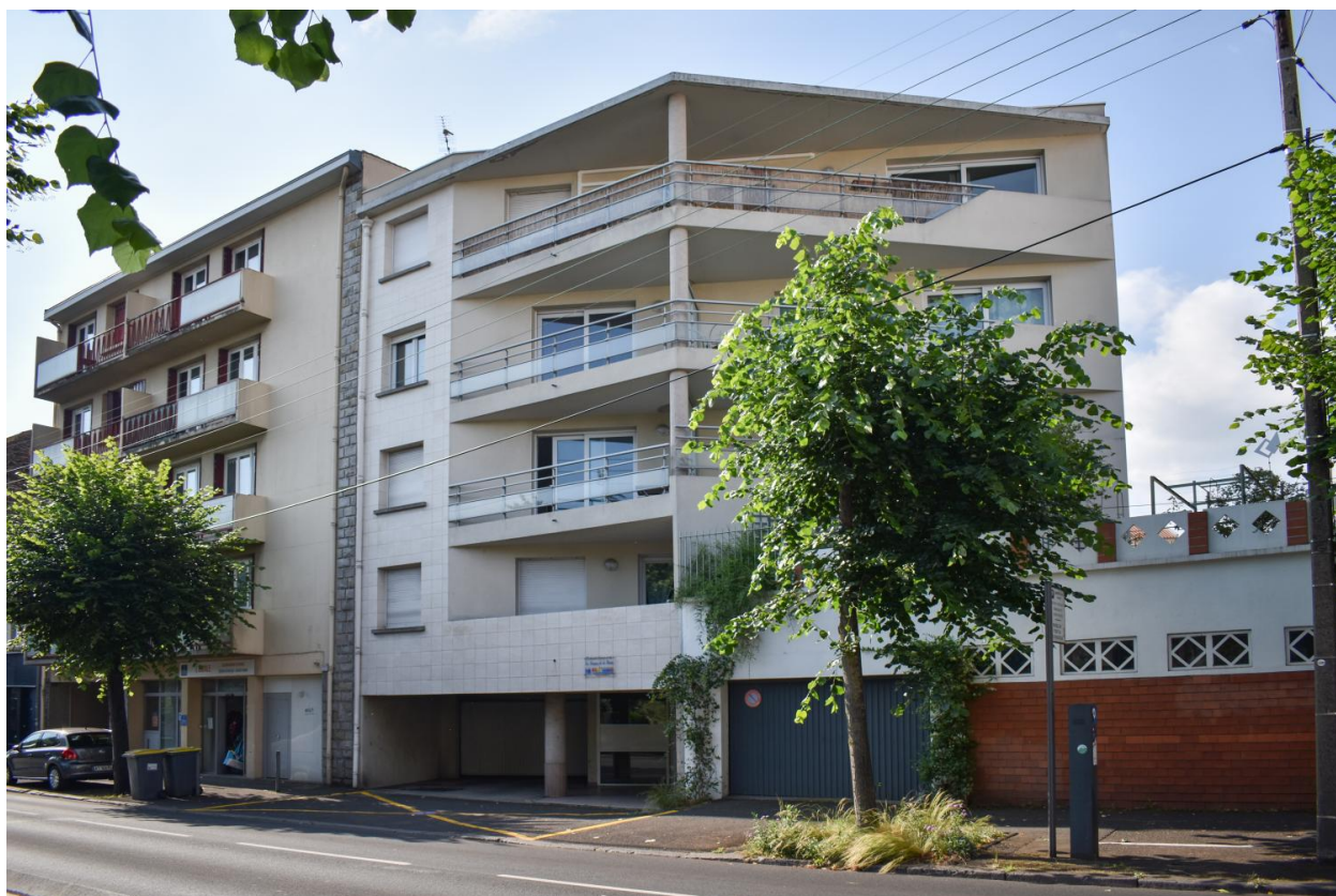
Façade sur le boulevard Jean-Jaurès
