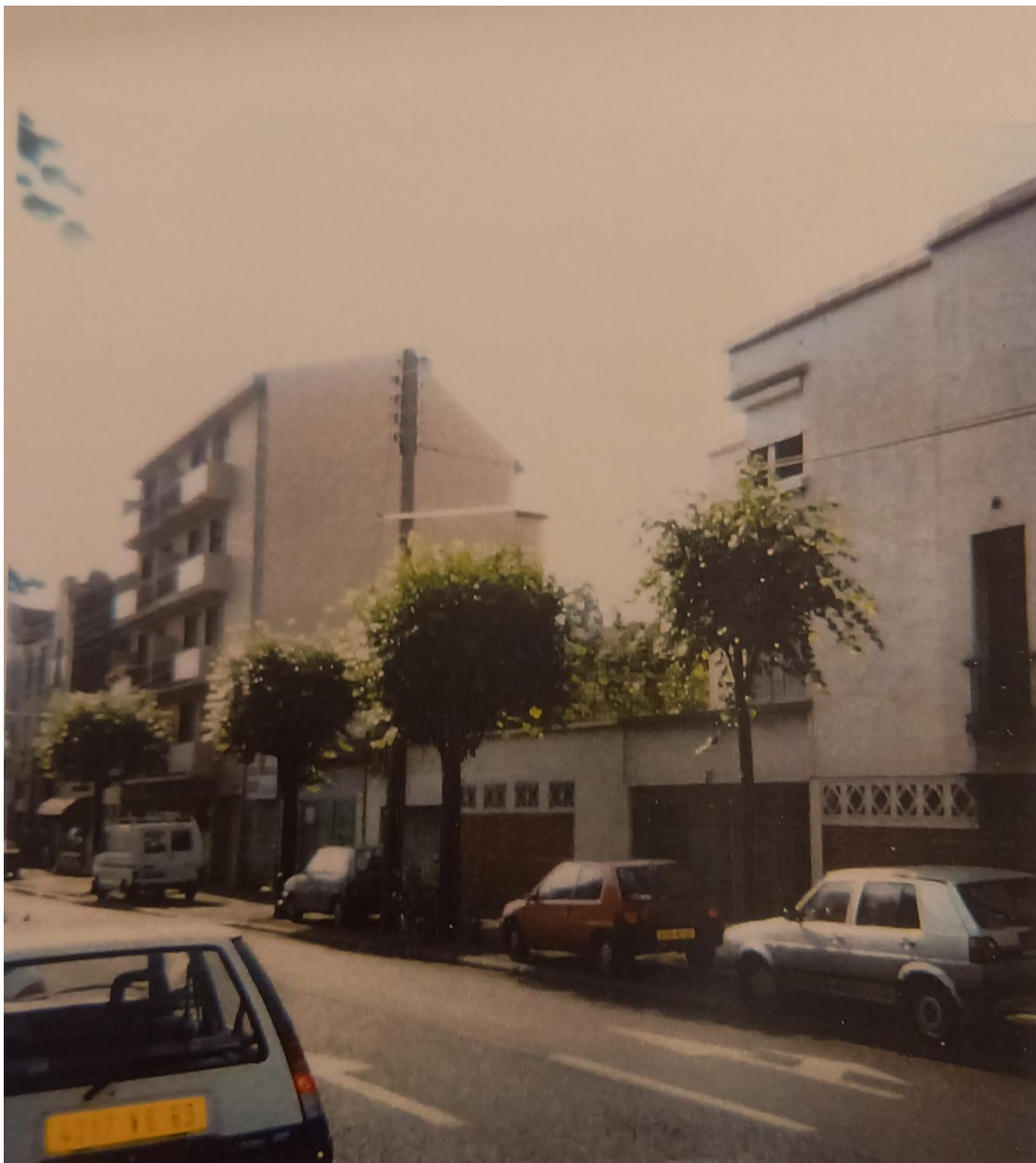
Façades sur le boulevard Jean-Jaurès (avant 2000)
