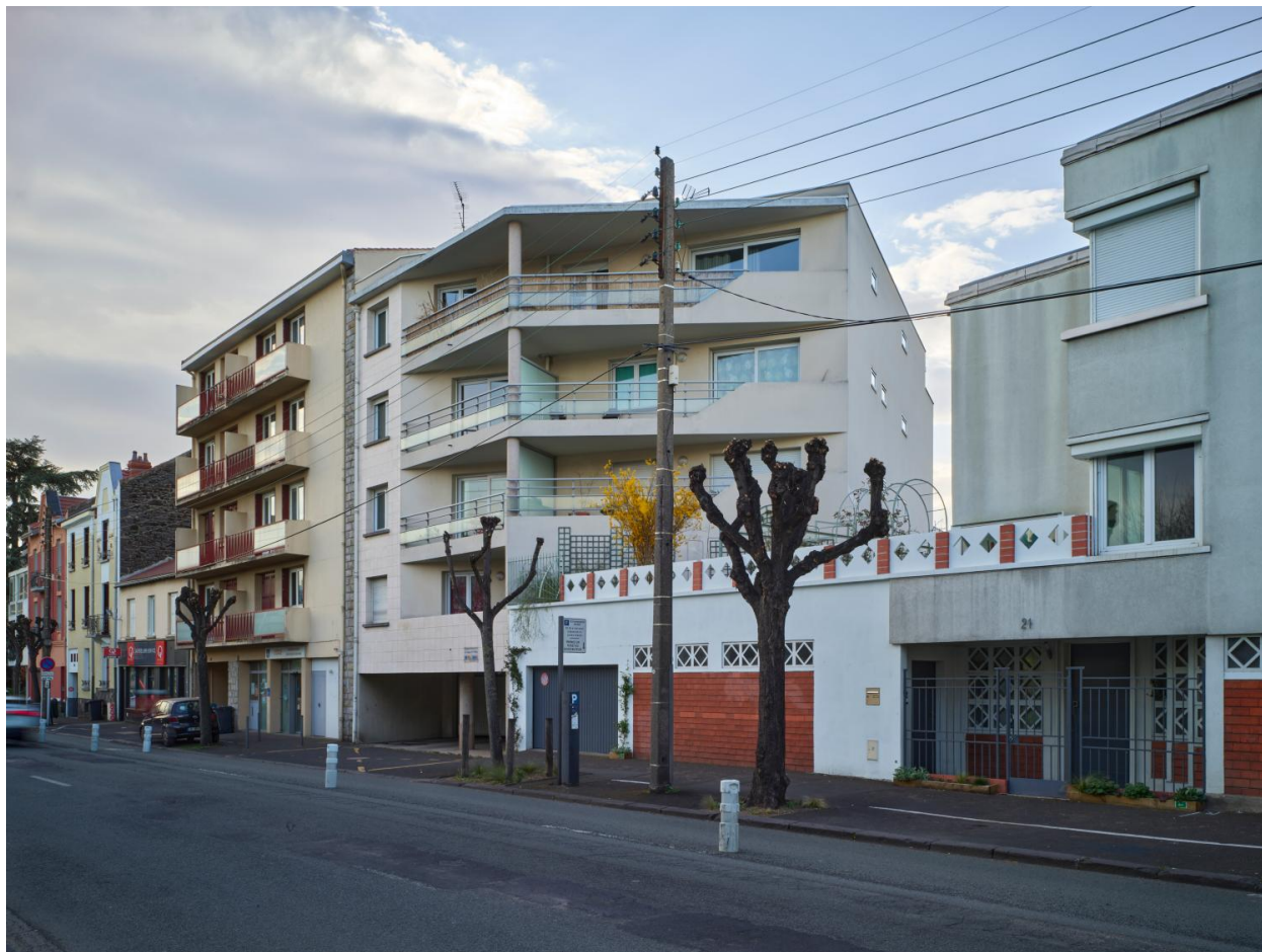
Façade sur le boulevard Jean-Jaurès
