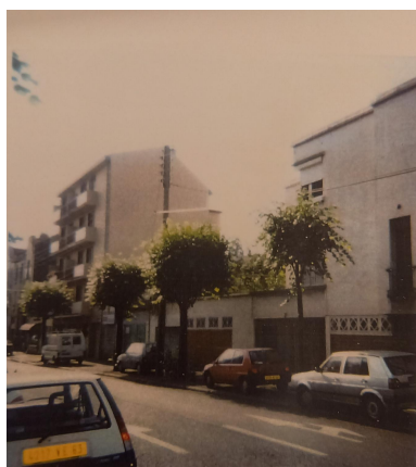
Façades sur le boulevard Jean-Jaurès (avant 2000) Repro. Félicie Fougère , Autr. Jean-Claude Breuil IVR84_20246302056NUCA
