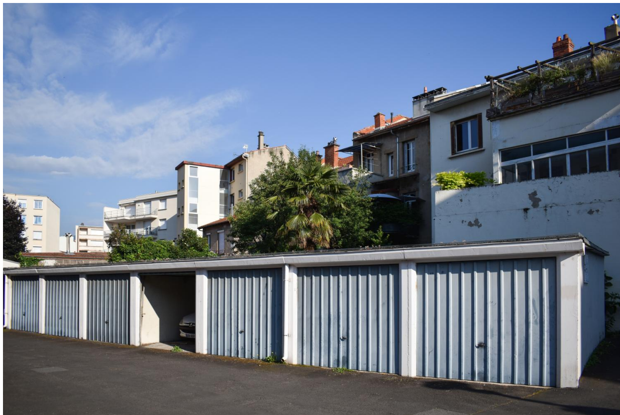
Elévations postérieures et garages
