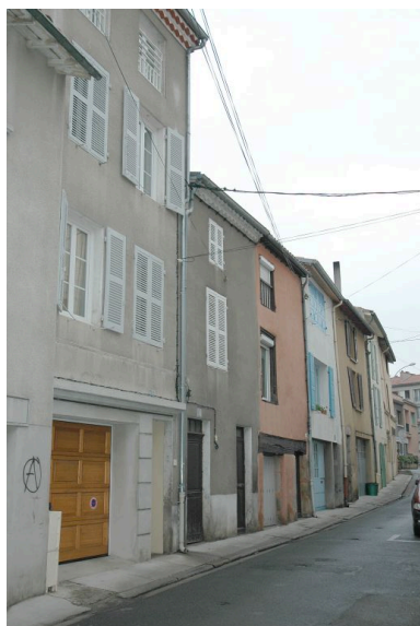
Vue de situation (2e maison à gauche).
