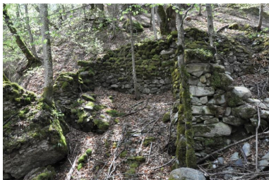
Vestiges du moulin. Phot. Clara Bérelle IVR84_20167301694NUCA
