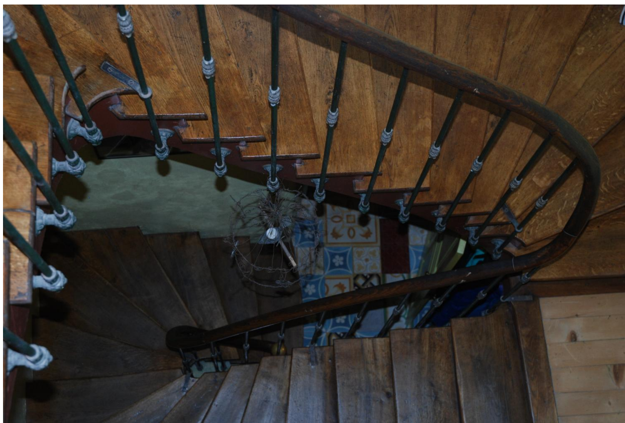
Vue intérieure : escalier en bois.
