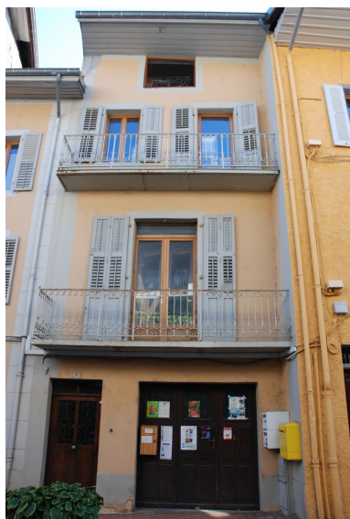
Vue d'ensemble de la façade sur la rue (n°97). Phot. Caroline Guibaud IVR84_20247301685NUCA
