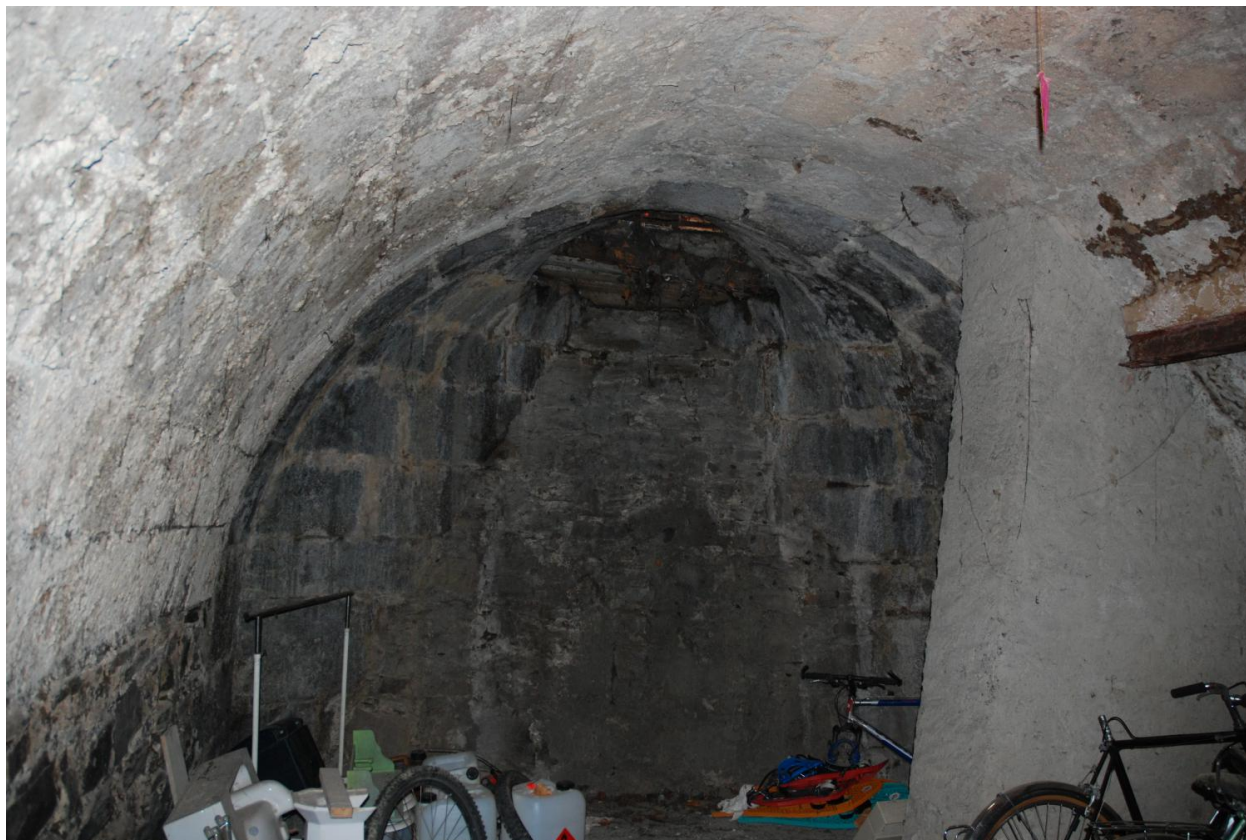
Vue intérieure de la cave.
