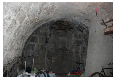
Vue intérieure de la cave. Phot. Caroline Guibaud IVR84_20247301682NUCA
