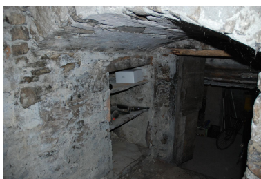
Vue intérieure de l'accès à la cave. Phot. Caroline Guibaud IVR84_20247301683NUCA
