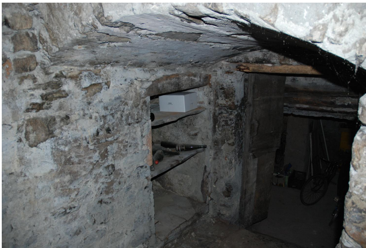
Vue intérieure de l'accès à la cave.
