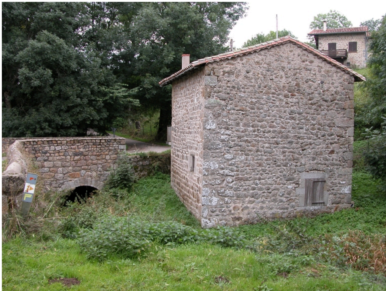
Vue d'ensemble du moulin, depuis le nord-ouest.
