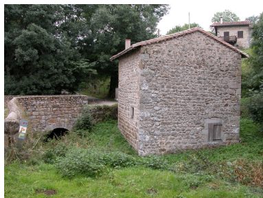
Vue d'ensemble du moulin, depuis le nord-ouest. Phot. Thierry Monnet IVR82_20124200860NUCA
