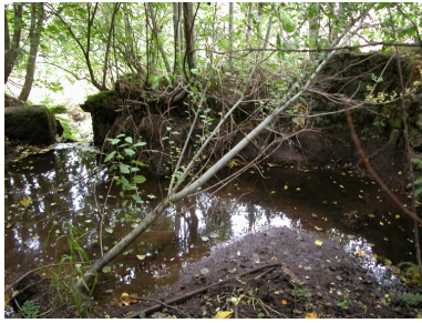
Réservoir au-dessus du moulin (aval). Phot. Thierry Monnet IVR82_20124200863NUCA
