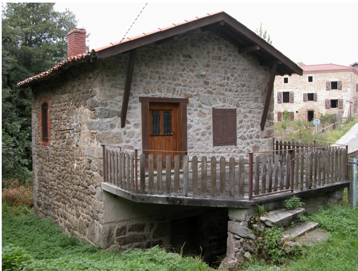
Vue d'ensemble du moulin, depuis le sud-est.
