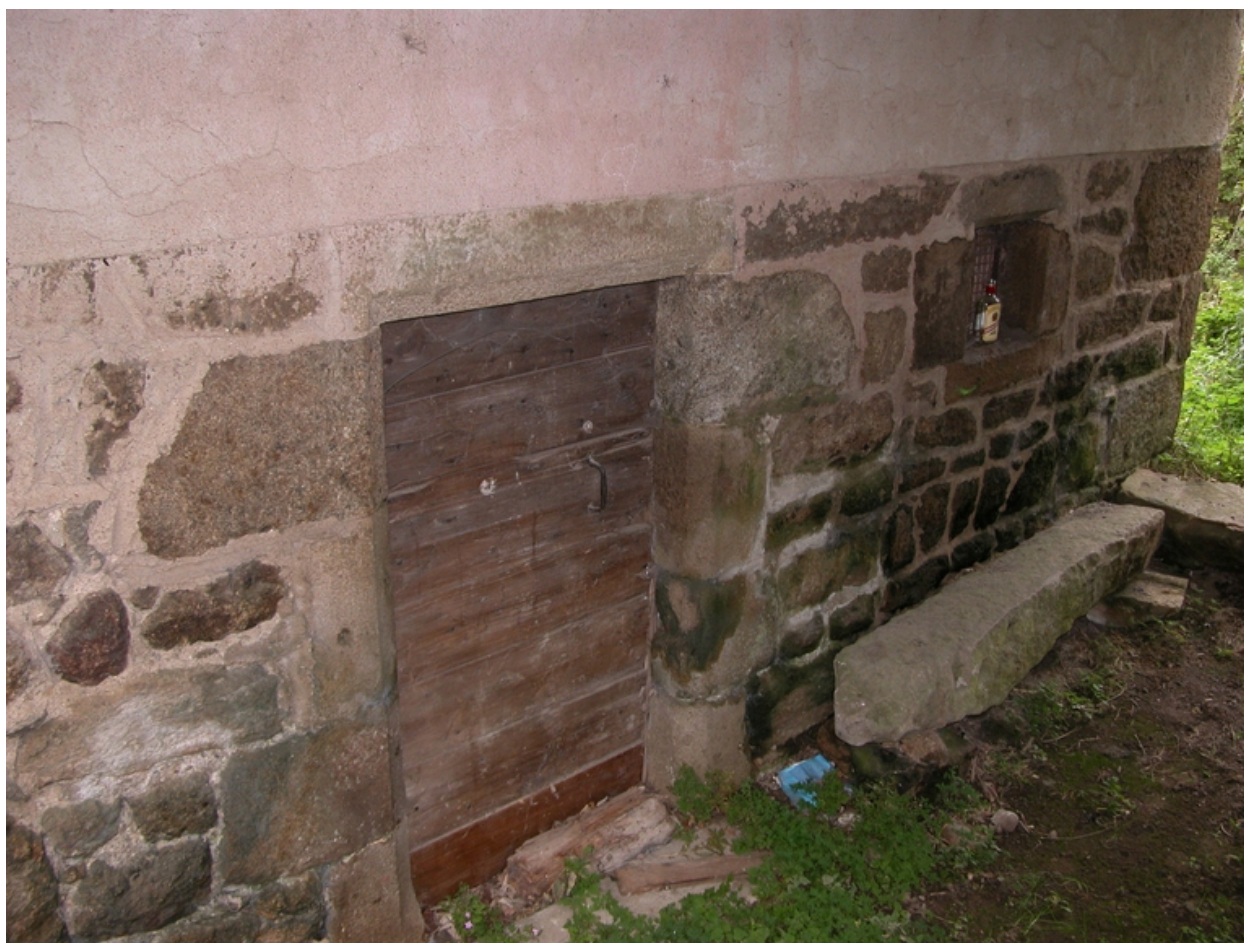
Façade est du moulin, ouvertures de l'étage de soubassement.
