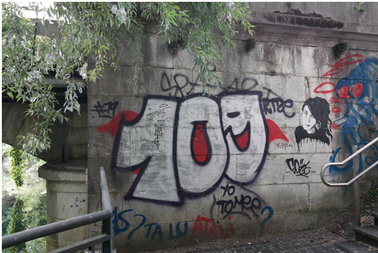
Pont Neuf, détail d'un mur de soutainement
