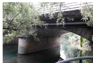
Pont Neuf, détail d'une voûte en aval Phot. Pascale Renard IVR84_20207403838NUCA
