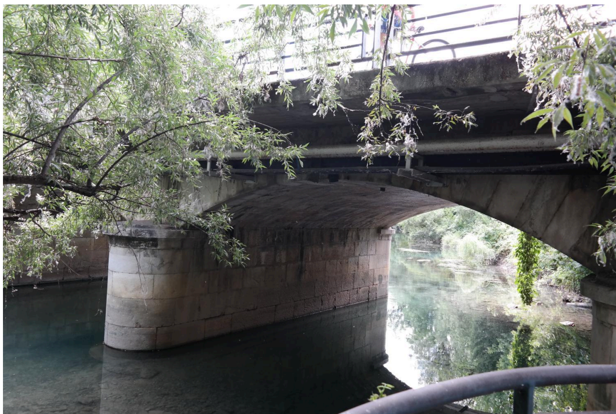
Pont Neuf, détail d'une voûte en aval
