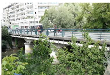
Pont Neuf, vue de la face amont Phot. Pascale Renard IVR84_20207403837NUCA
