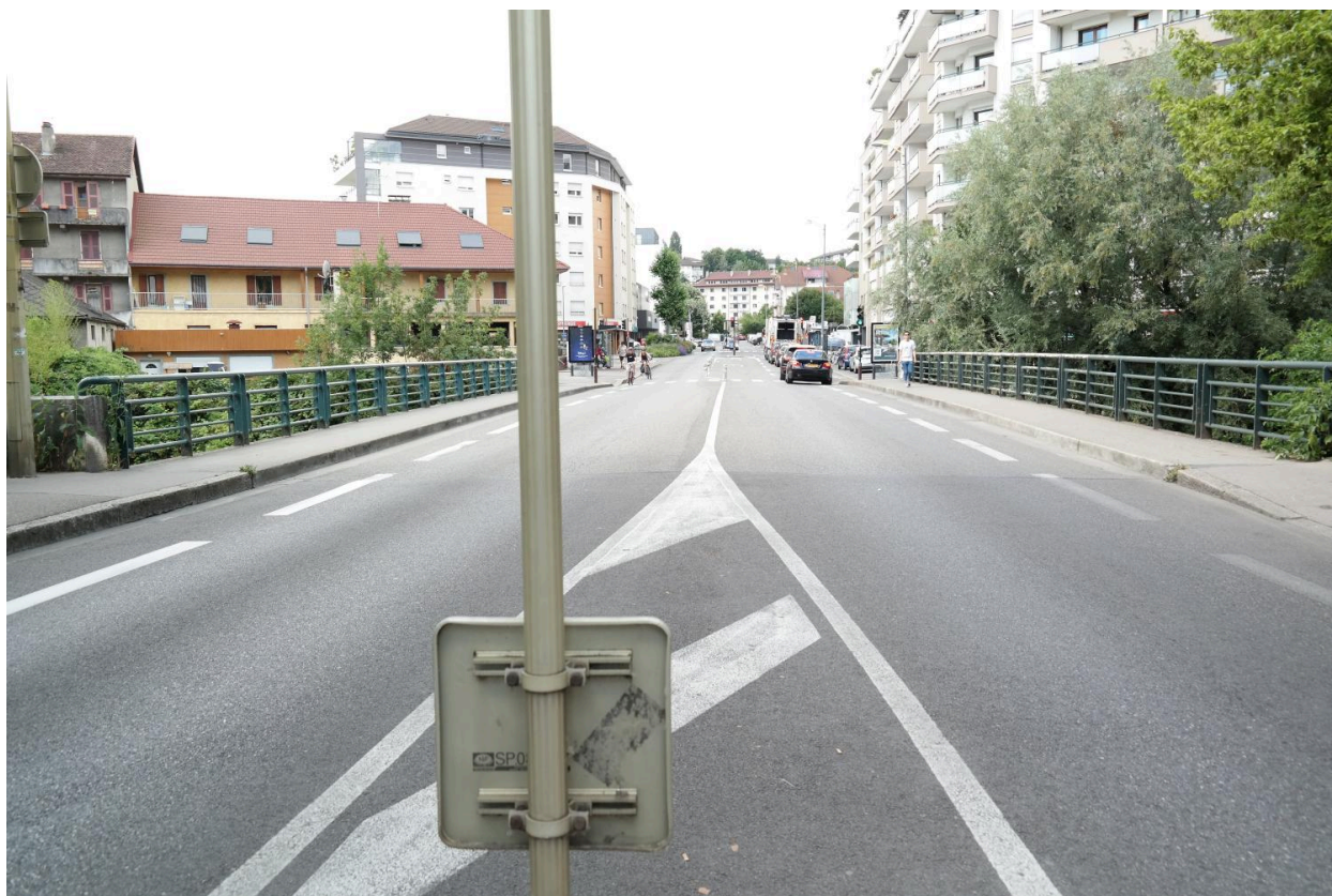
Pont Neuf, vue de la chaussée
