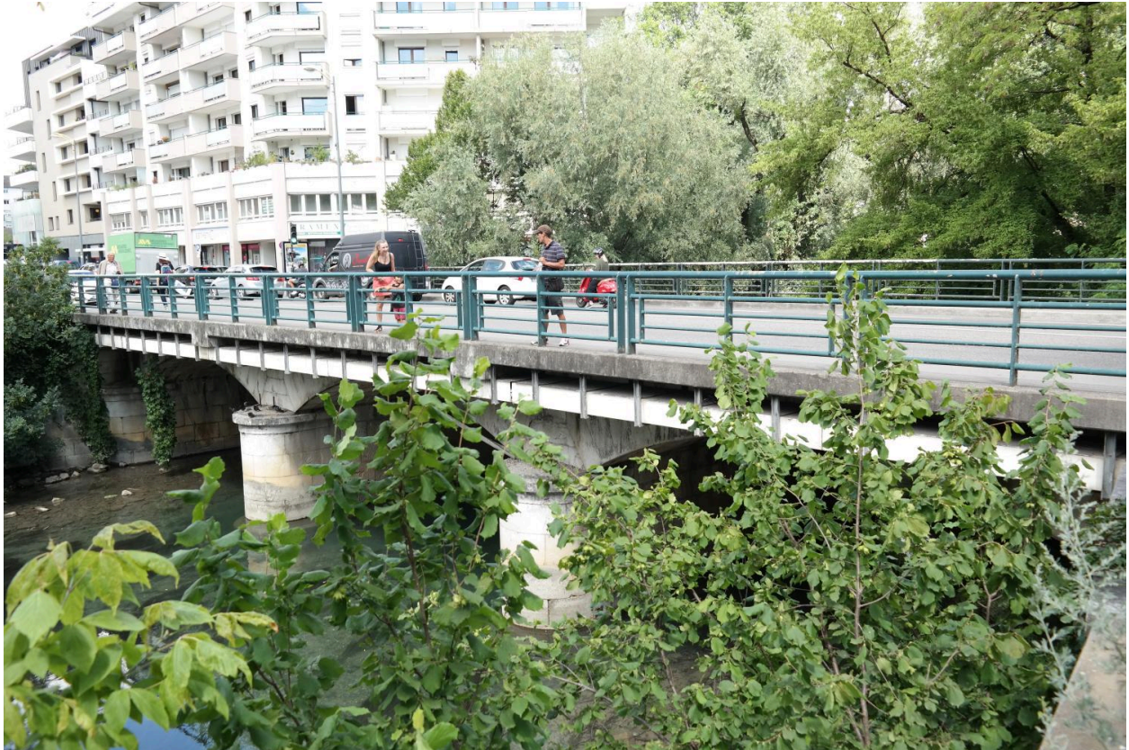
Pont Neuf, vue de la face amont
