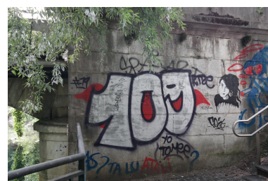
Pont Neuf, détail d'un mur de soutènement Phot. Pascale Renard IVR84_20207403841NUCA
