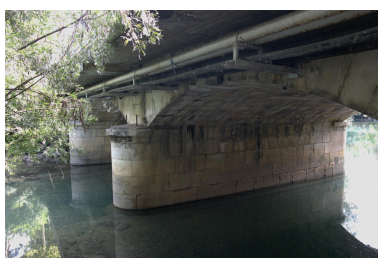
Pont Neuf, détail de l'élargissement et d'une pile Phot. Pascale Renard IVR84_20207403840NUCA
