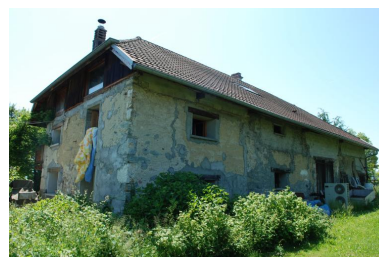
Vue arrière. Phot. Thierry Monnet IVR84_20187301303NUCA
