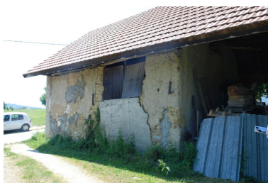
Vue arrière de la dépendance. Phot. Thierry Monnet IVR84_20187301305NUCA
