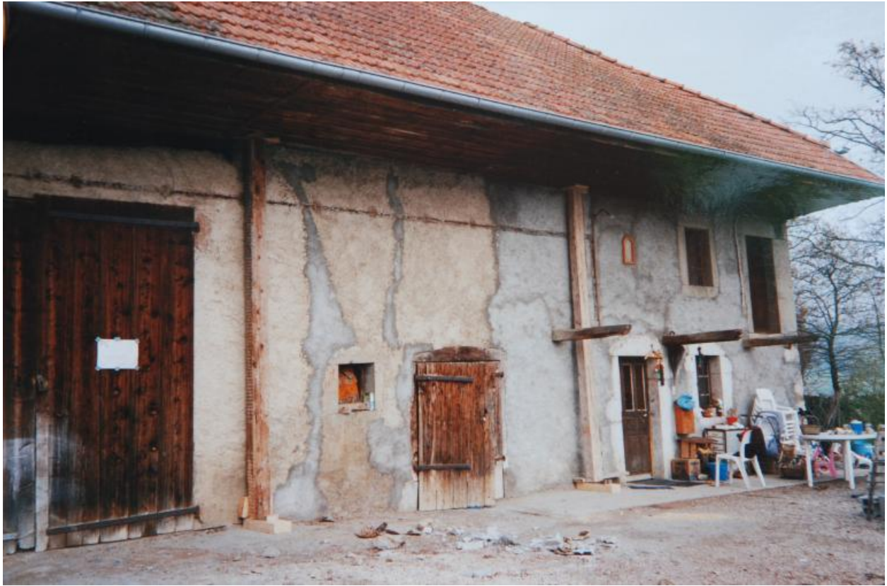
Vue d'ensemble dans le 4e quart du 20e siècle (avant les travaux de transformation en habitation) (A privées).
