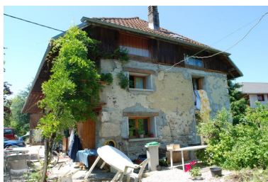
Vue du mur pignon côté habitation. Phot. Thierry Monnet IVR84_20187301302NUCA
