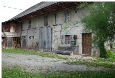
Vue du bâtiment principal. Phot. Caroline Guibaud IVR84_20207402547NUCA
