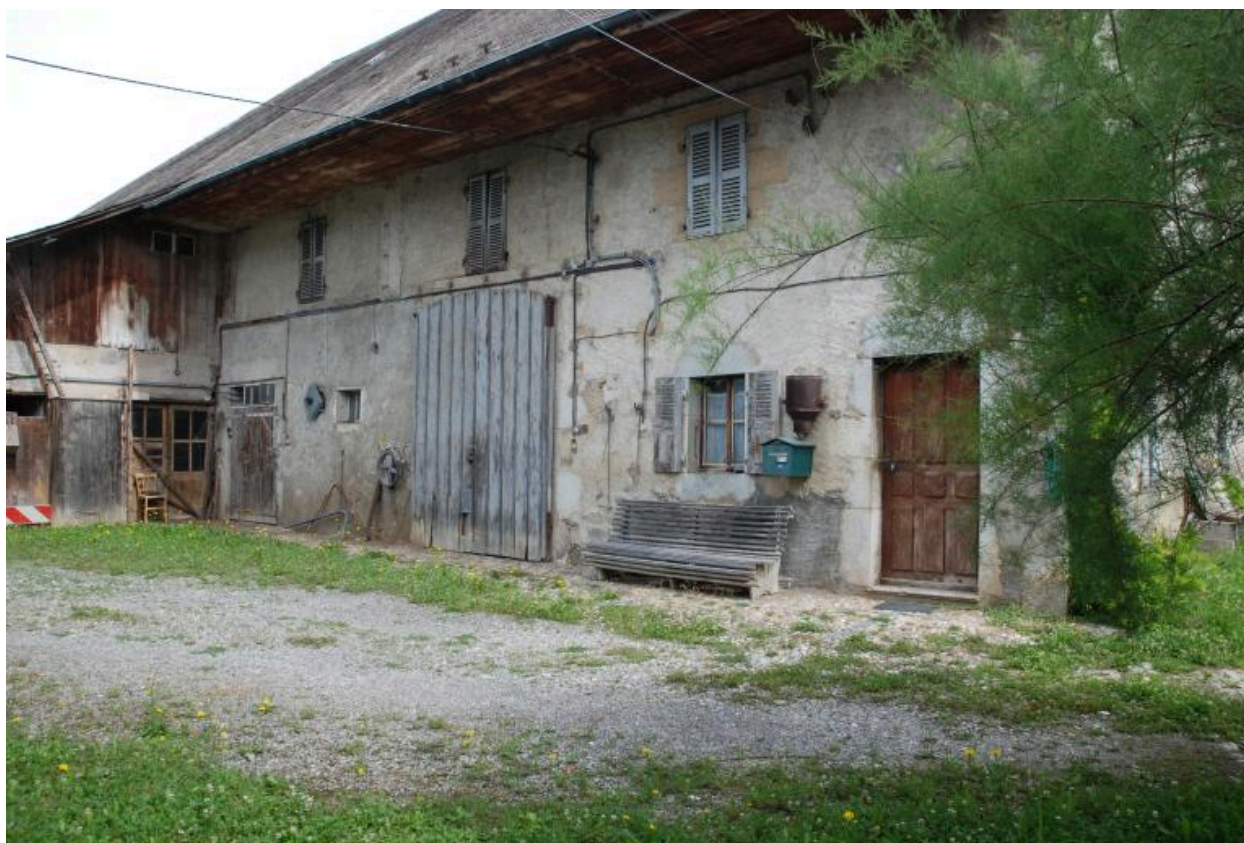
Vue du bâtiment principal.
