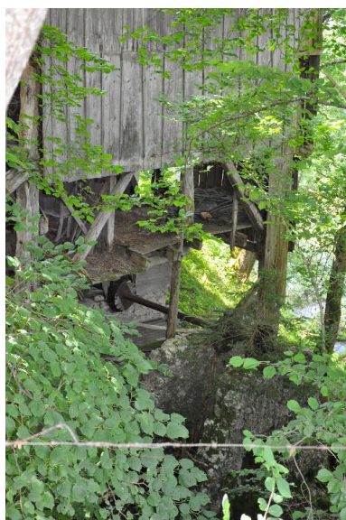
Vue de la façade nord de la scierie où l'on voit encore l'emplacement et l'axe de la roue.
