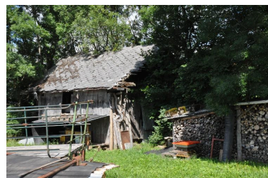
Façade sud de la scierie. Phot. Clara Bérelle IVR82_20137301782NUCA
