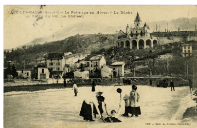
Au centre, la façade postérieure Repro. François Fouger IVR82_20127300973NUCB
