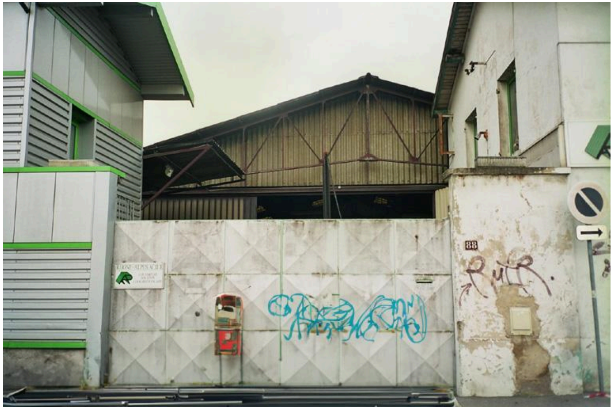
Entrée principale de l'usine Nardy
