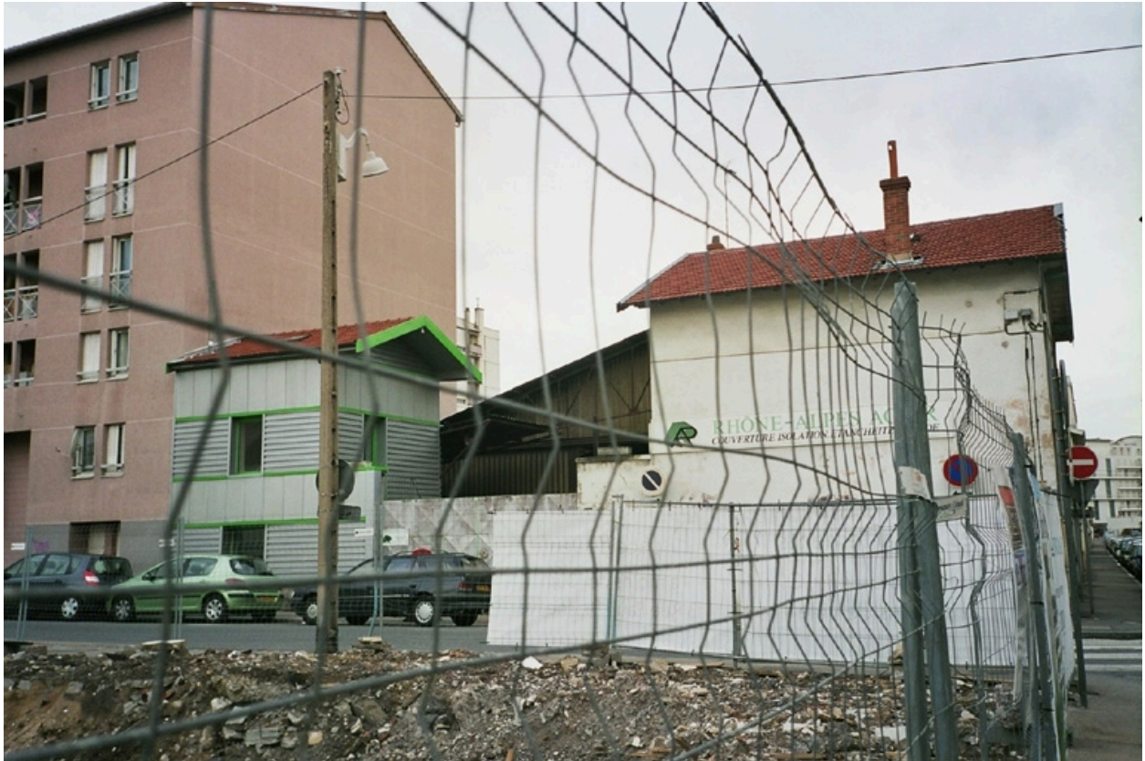
Vue ouest du site
