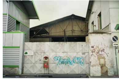
Entrée principale de l'usine Nardy Phot. Nadine Halitim-Dubois IVR82_20076901856NUCA
