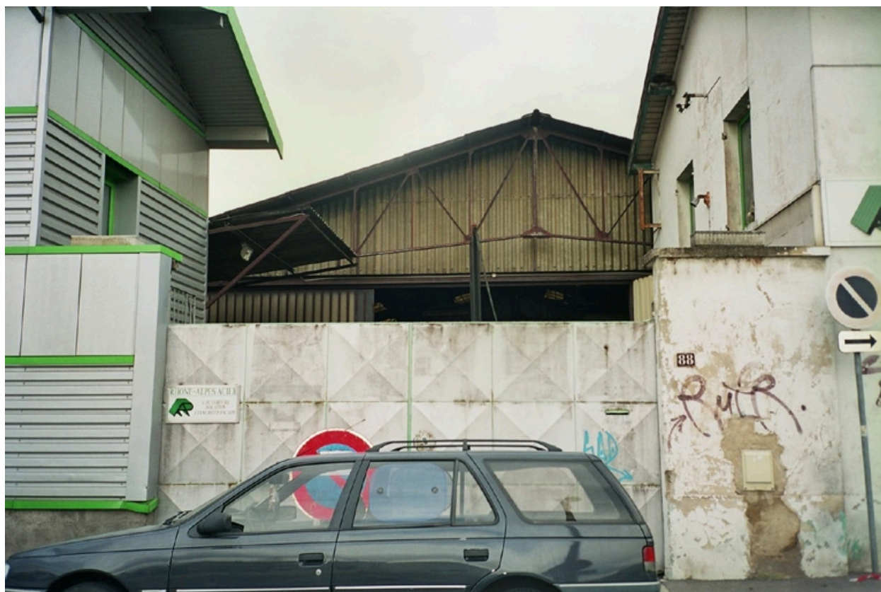
Vue nord du site, entrée principale
