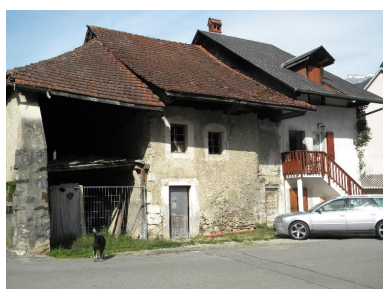
Vue d'ensemble. Phot. Jérôme Daviet IVR82_20147400086NUCA
