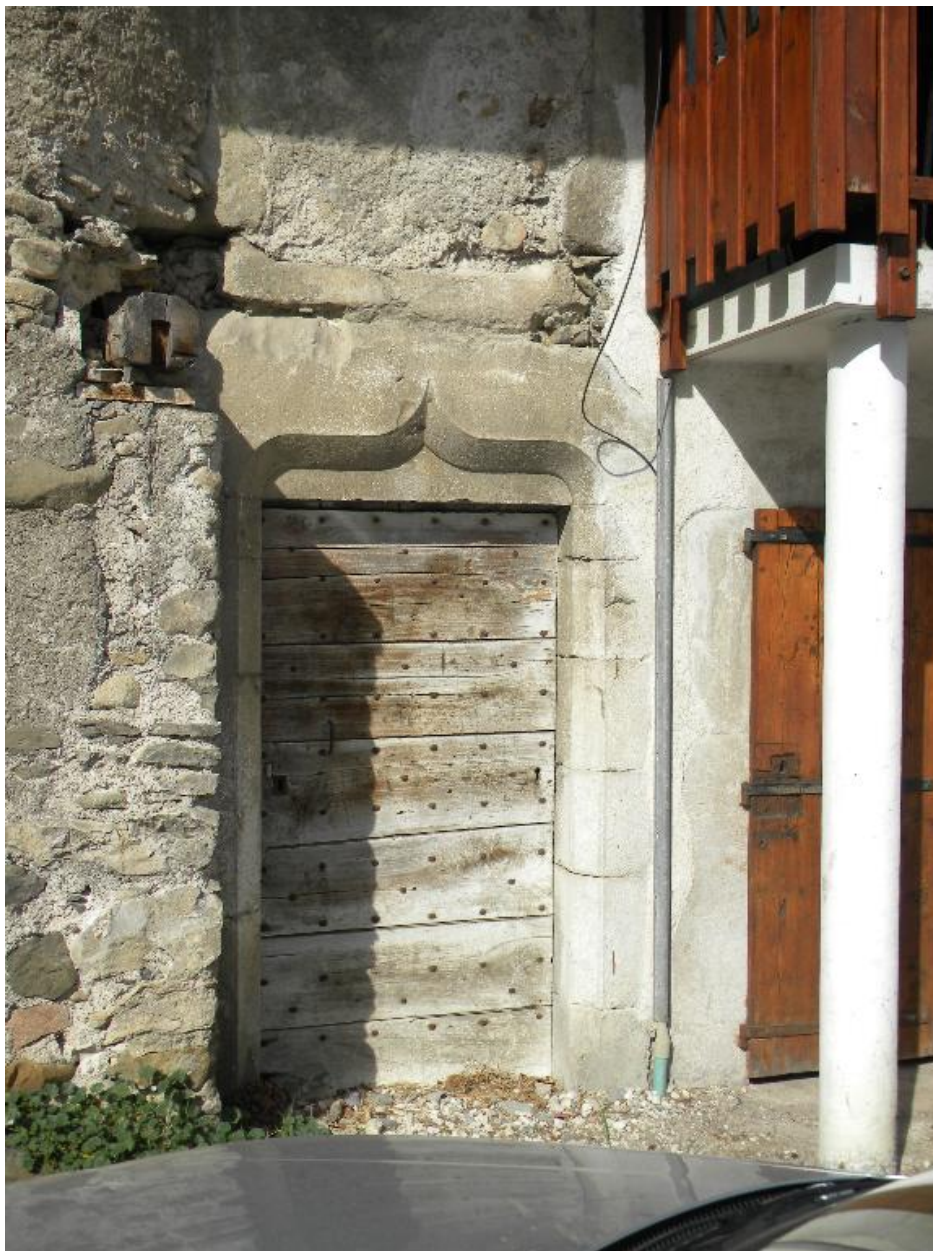
Détail de la porte principale.
