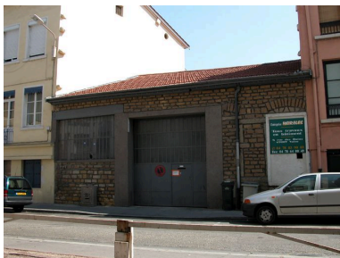
Elévation rue des Bains Phot. Véronique Belle IVR82_20046902151NUCA
