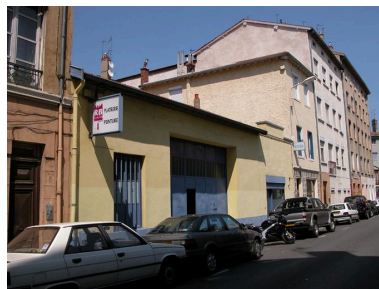
Elévation rue des Deux-Places Phot. Véronique Belle IVR82_20046902152NUCA
