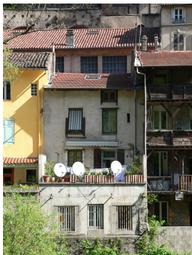
Façade sur Gère Phot. Isabelle Dupuis IVR82_20093800456NUCA
