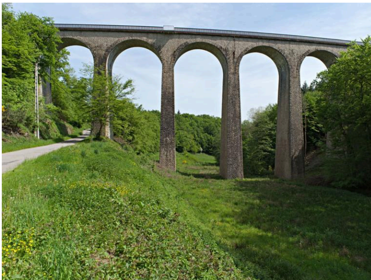
Vue générale du viaduc en contre-plongée.
