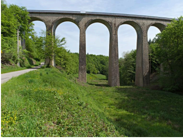
Vue générale du viaduc en contre-plongée. Phot. Jean-Michel Périn IVR83_20150300053NUC4A
