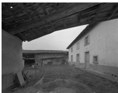
Vue de la cour depuis le passage couvert. Phot. Eric Dessert IVR82_20024201413V
