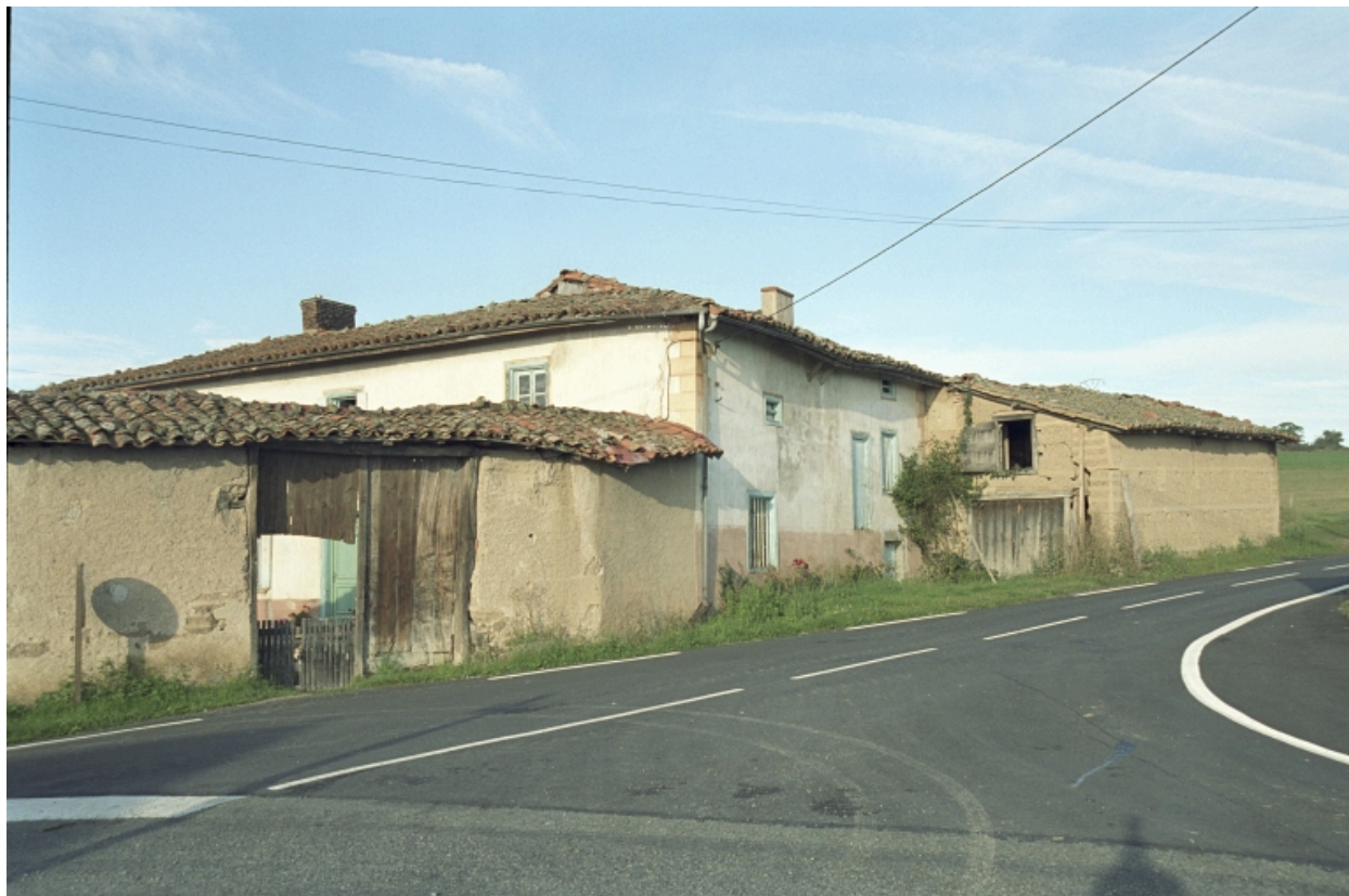
Vue d'ensemble depuis la route, du sud.
