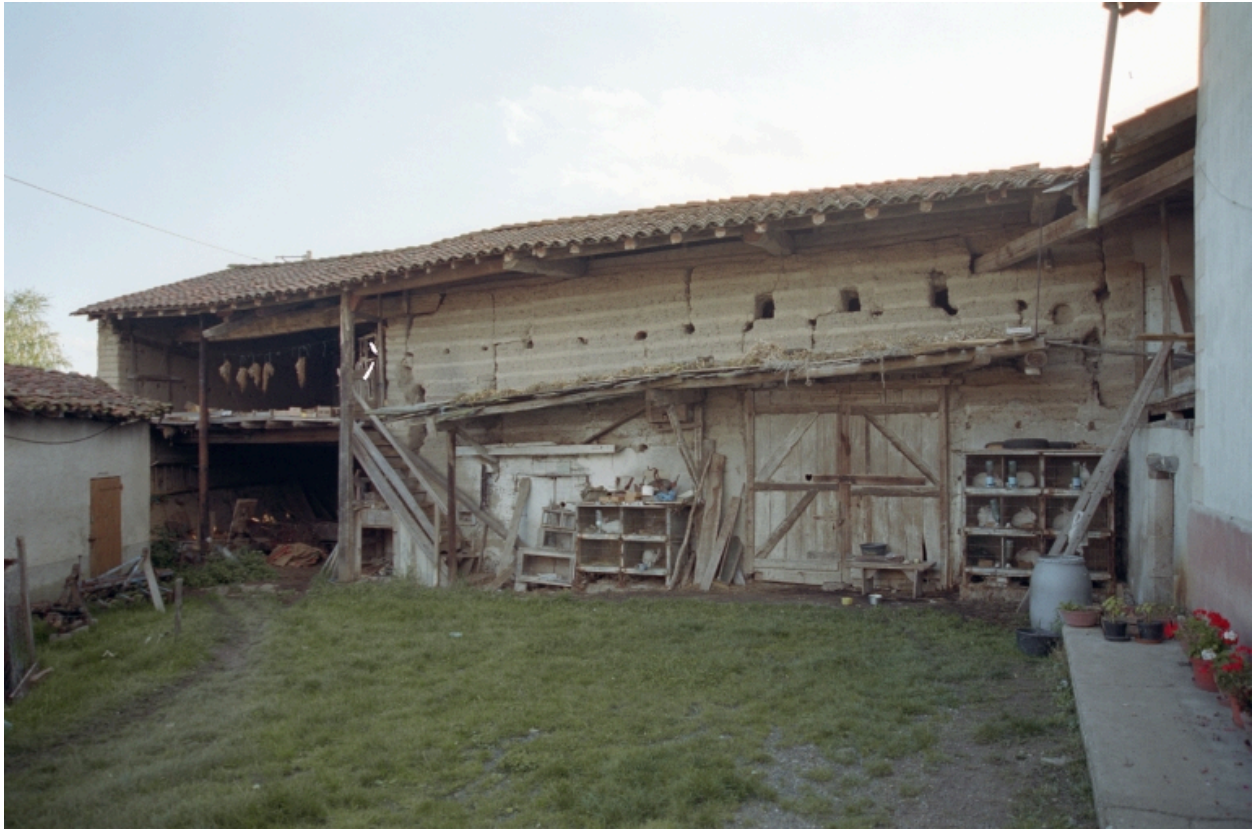
Vue d'ensemble de la grange-étable.
