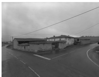
Vue d'ensemble des bâtiments depuis la route. Phot. Eric Dessert IVR82_20024201412V
