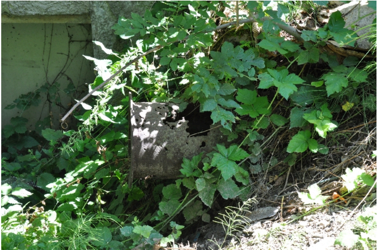
Vue de l'ancienne conduite forcée
