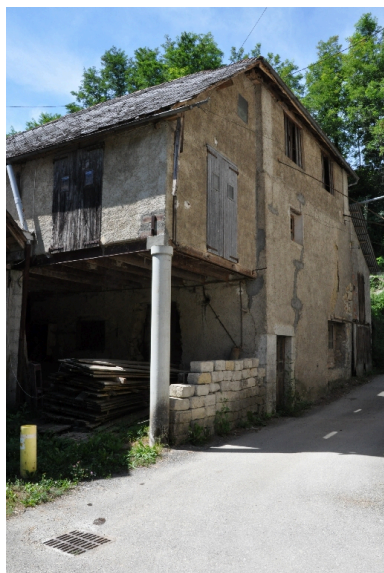
Vue de la façade nord-est Phot. Yannick Milleret IVR82_20117302079NUCA
