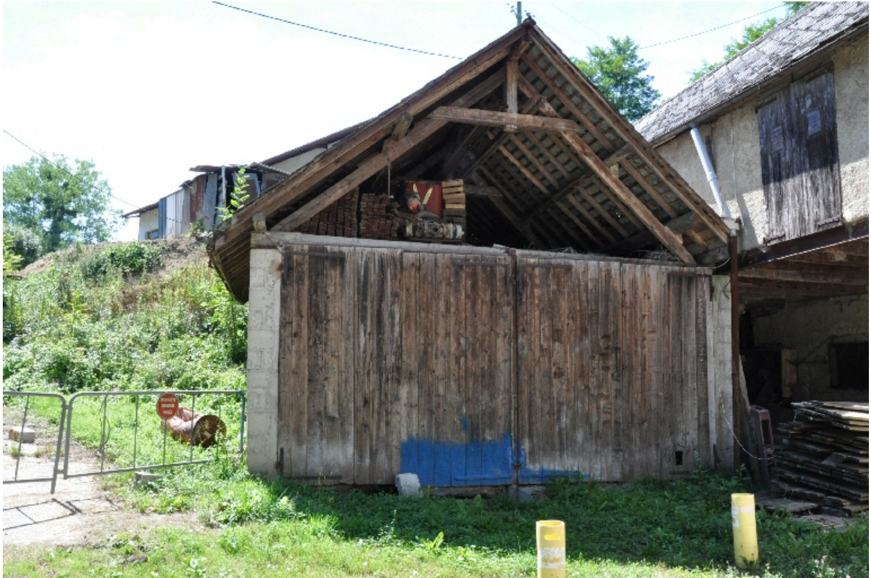
Vue de l'aile sud-est
