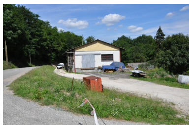
Vue sud-ouest du site avec la présence d'un bâtiment sur l'ancienne réserve d'eau Phot. Yannick Milleret IVR82_20117302082NUCA
