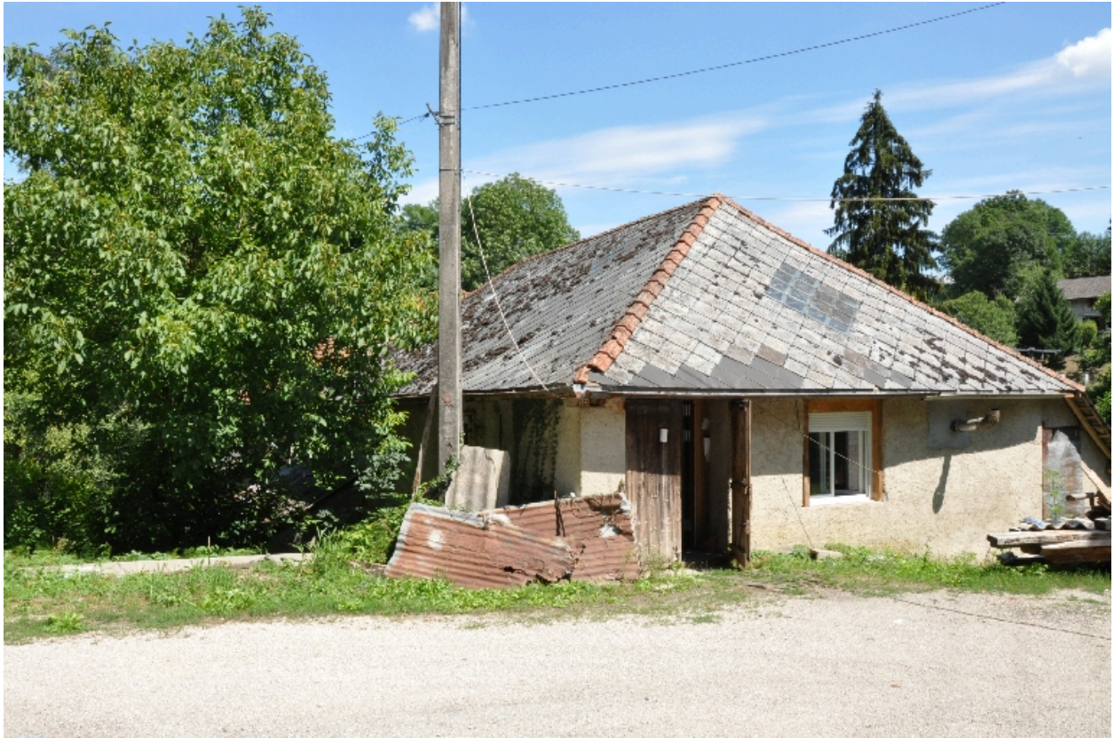
Vue de la façade sud-ouest
