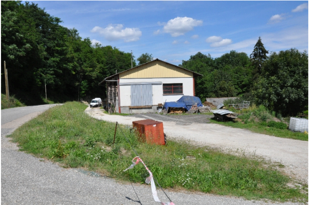
Vue sud-ouest du site avec la présence d'un bâtiment sur l'ancienne réserve d'eau
