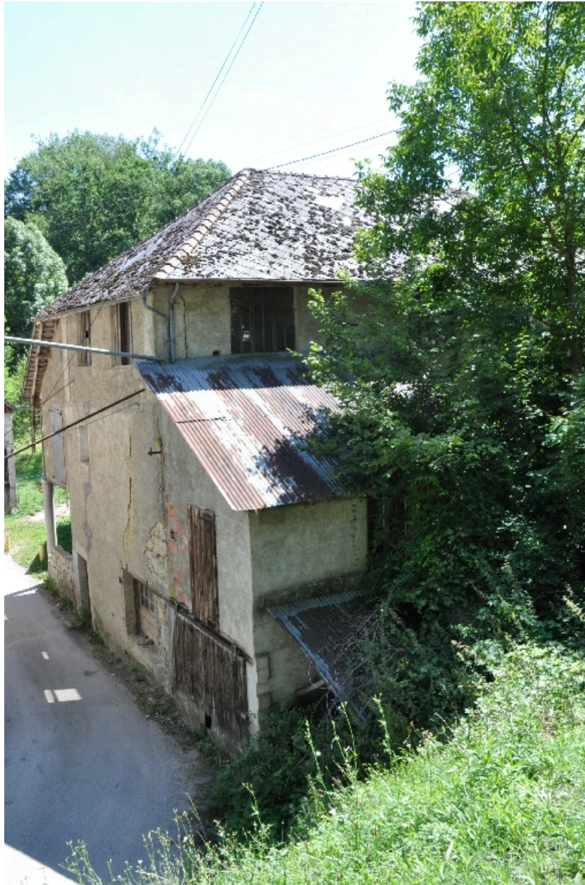
Vue générale du bâtiment du moulin et de la centrale électrique
