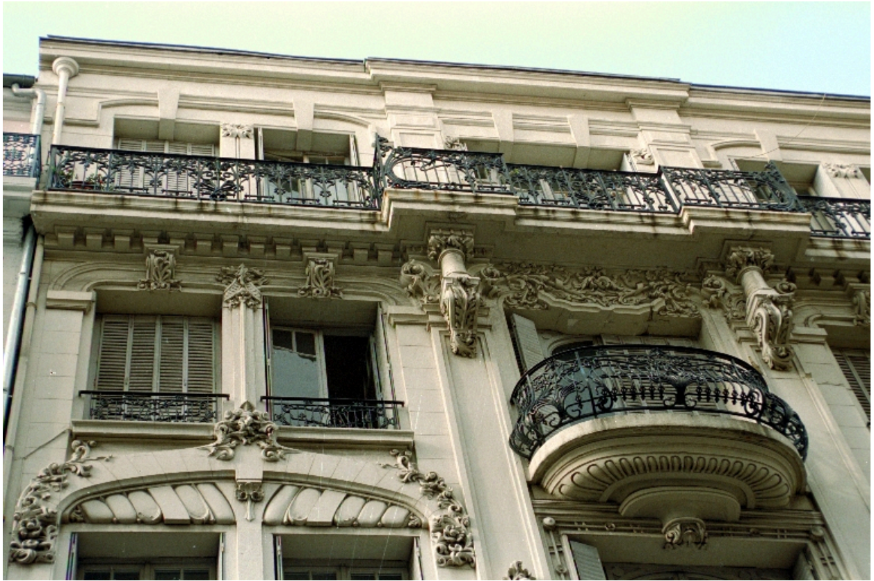
Façade principale. Détail des niveaux supérieurs
