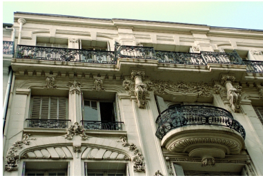
Façade principale. Détail des niveaux supérieurs Phot. Cendrine Sanquer IVR82_19974202088ZE
