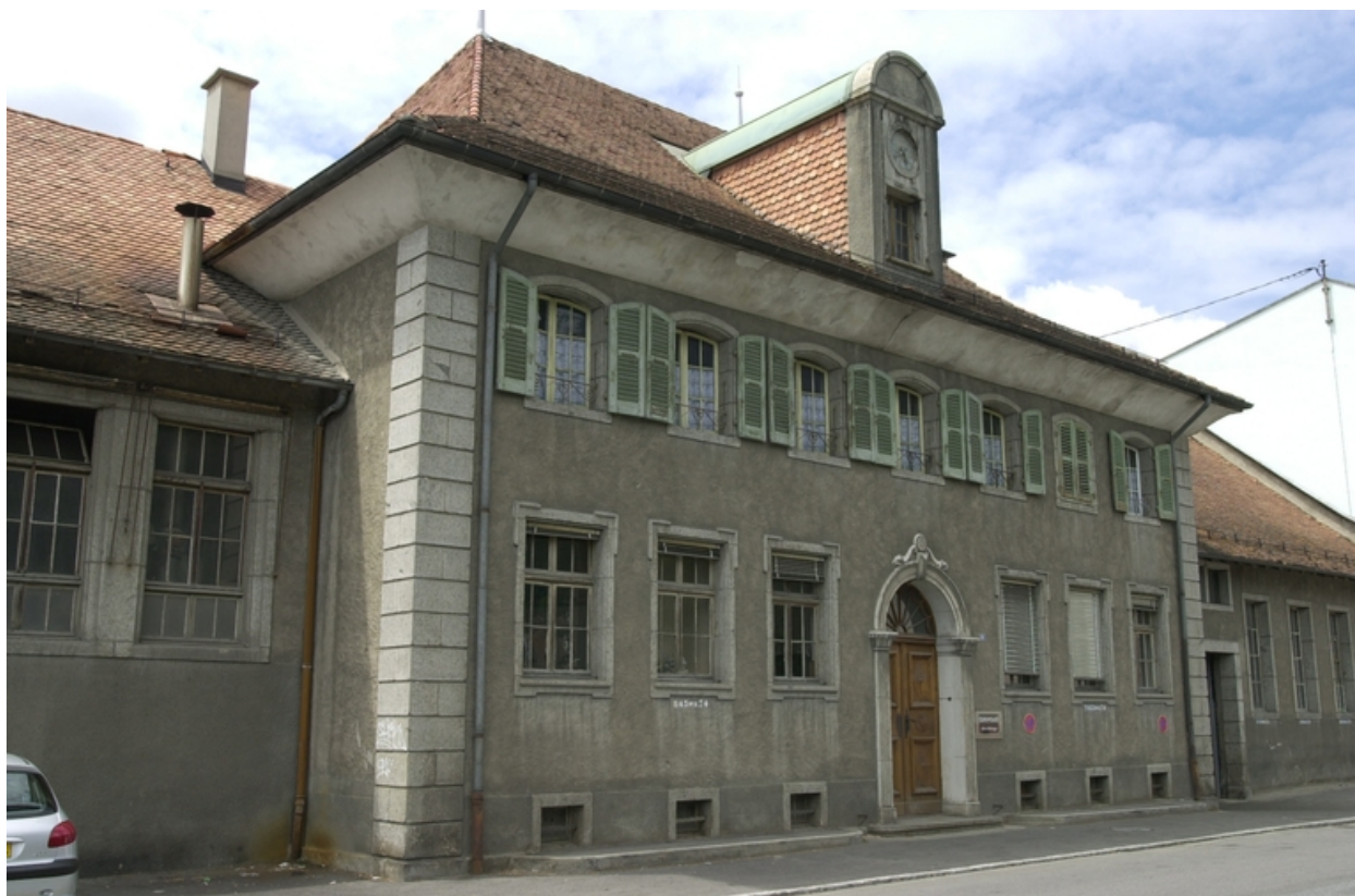
Vue d'ensemble : entrée principale avec encadrement académique
