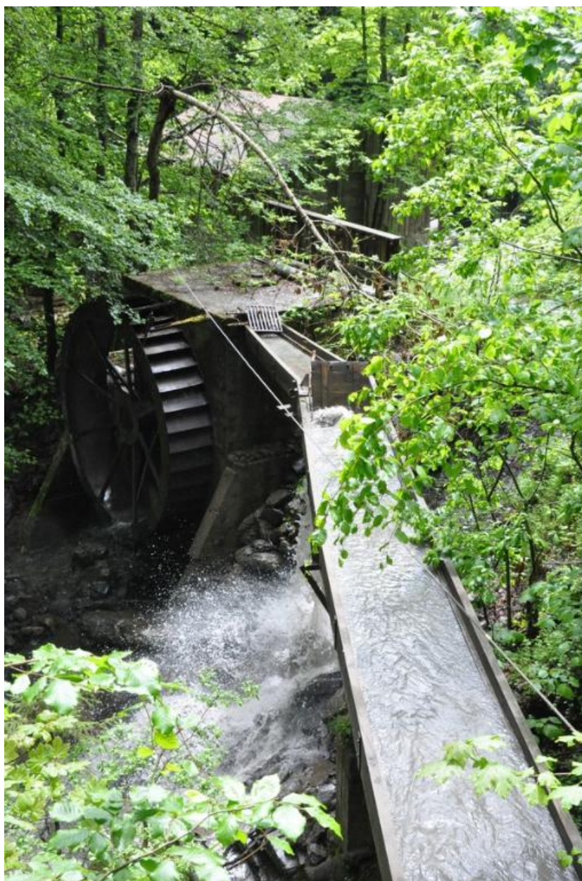
Vue de l'ancienne picocentrale sur laquelle a été installée une roue hydraulique.
