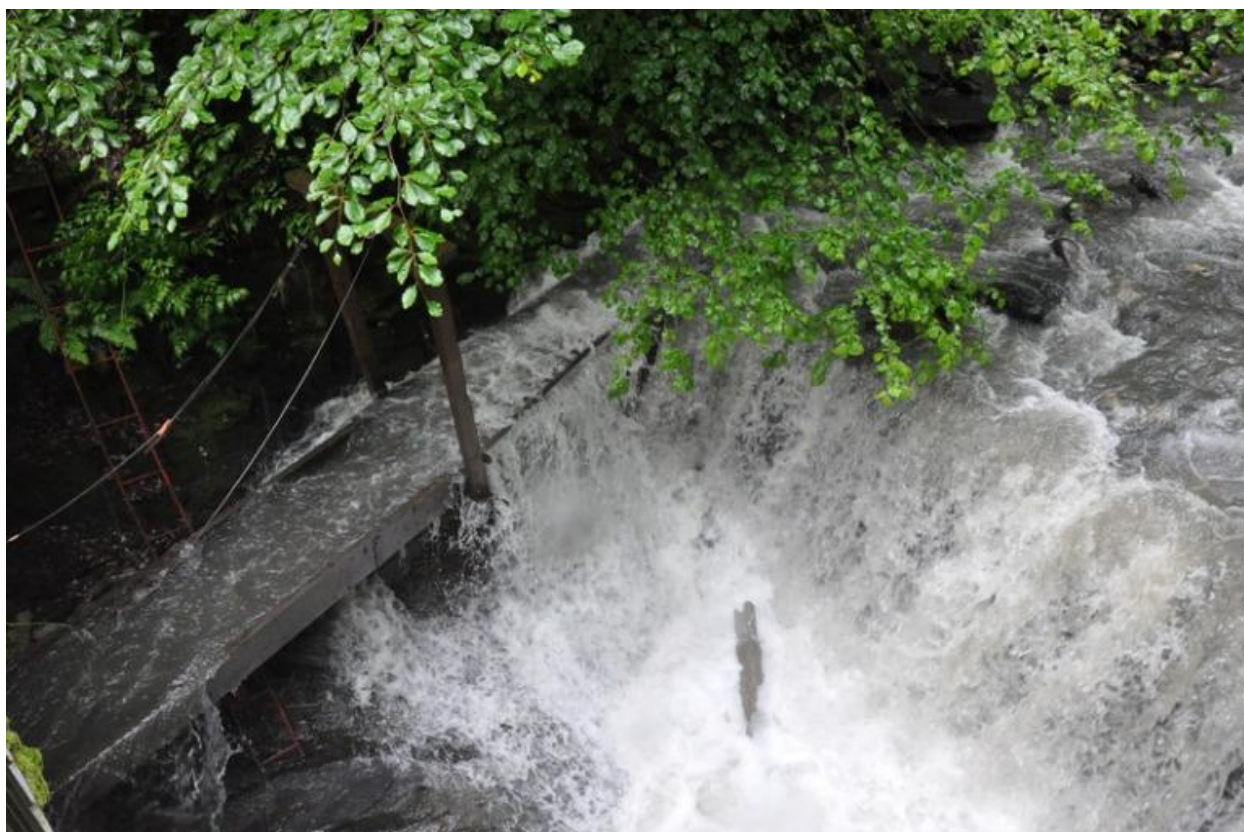
Vue de la prise d'eau.
