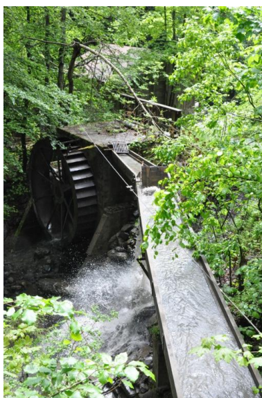
Vue de l'ancienne picocentrale sur laquelle a été installée une roue hydraulique. Phot. Clara Bérelle IVR84_20167302800NUCA
