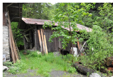
Vue de la scierie. IVR84_20167302795NUCA
