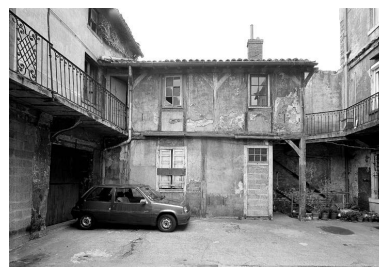
Corps de bâtiment reliant le corps de bâtiment sur rue et le corps de bâtiment sur cour, côté sud de la parcelle Phot. Martial Couderette IVR82_20006900530P
