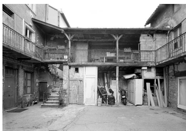
Corps de bâtiment reliant le corps de bâtiment sur rue et le corps de bâtiment sur cour, côté nord de la parcelle Phot. Martial Couderette IVR82_20006900529P
