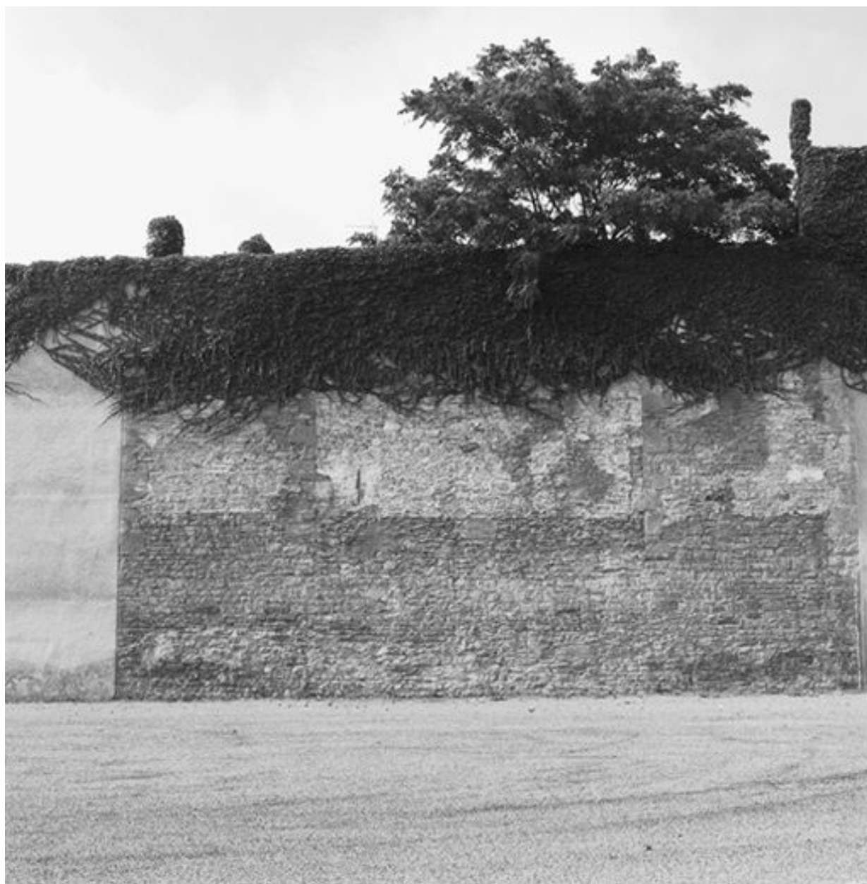
Mur de clôture fermant la parcelle à l'est
