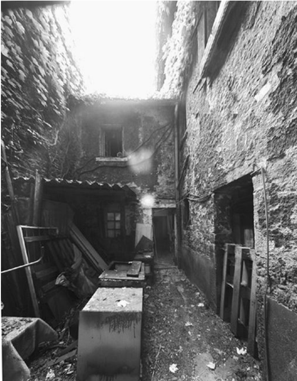
Partie sud de la courette située en fond de parcelle
