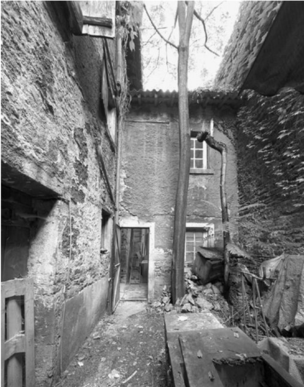
Partie nord de la courette située en fond de parcelle
