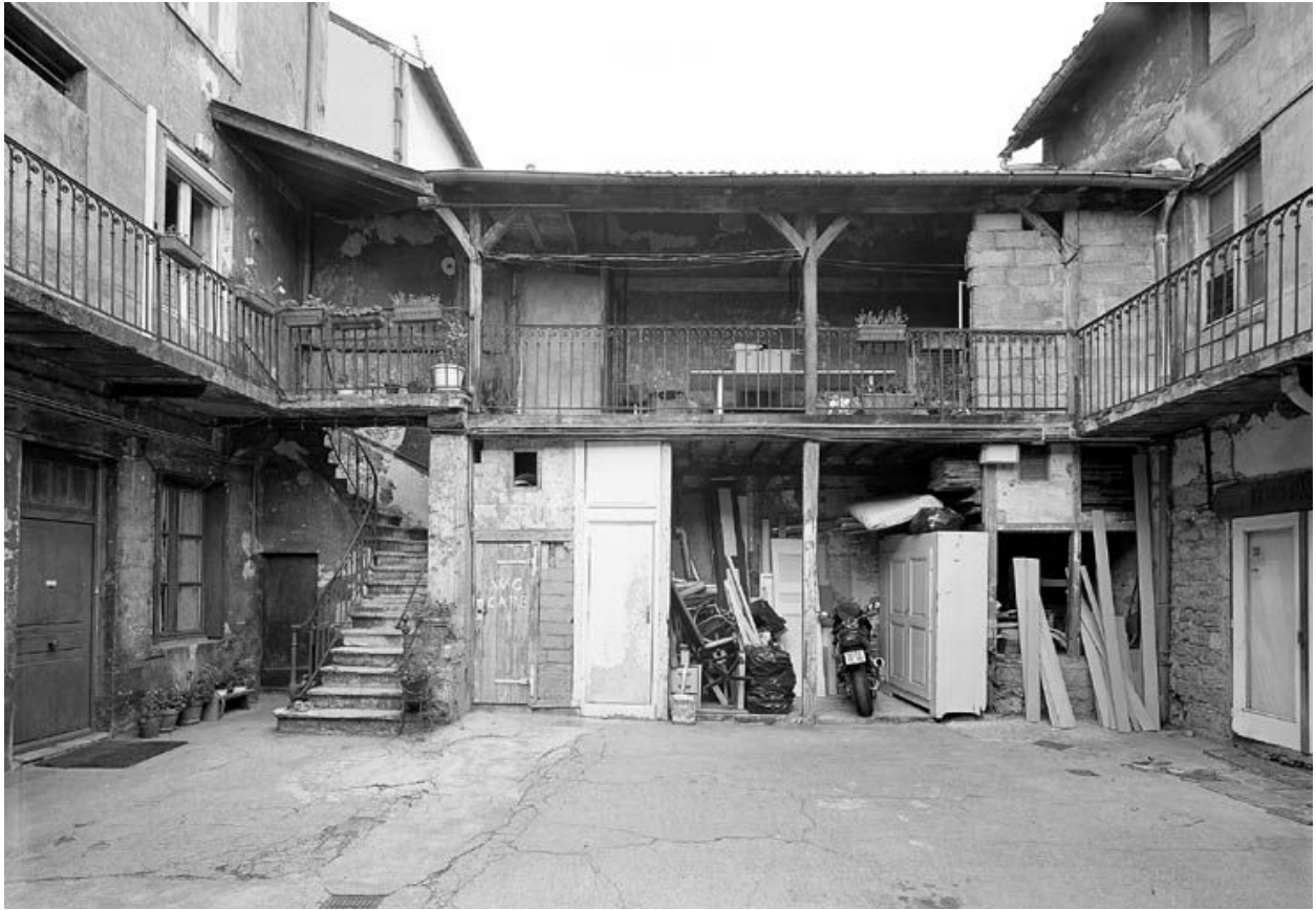
Corps de bâtiment reliant le corps de bâtiment sur rue et le corps de bâtiment sur cour, côté nord de la parcelle
