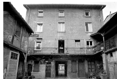
Elévation postérieure du corps de bâtiment sur rue Phot. Martial Couderette
