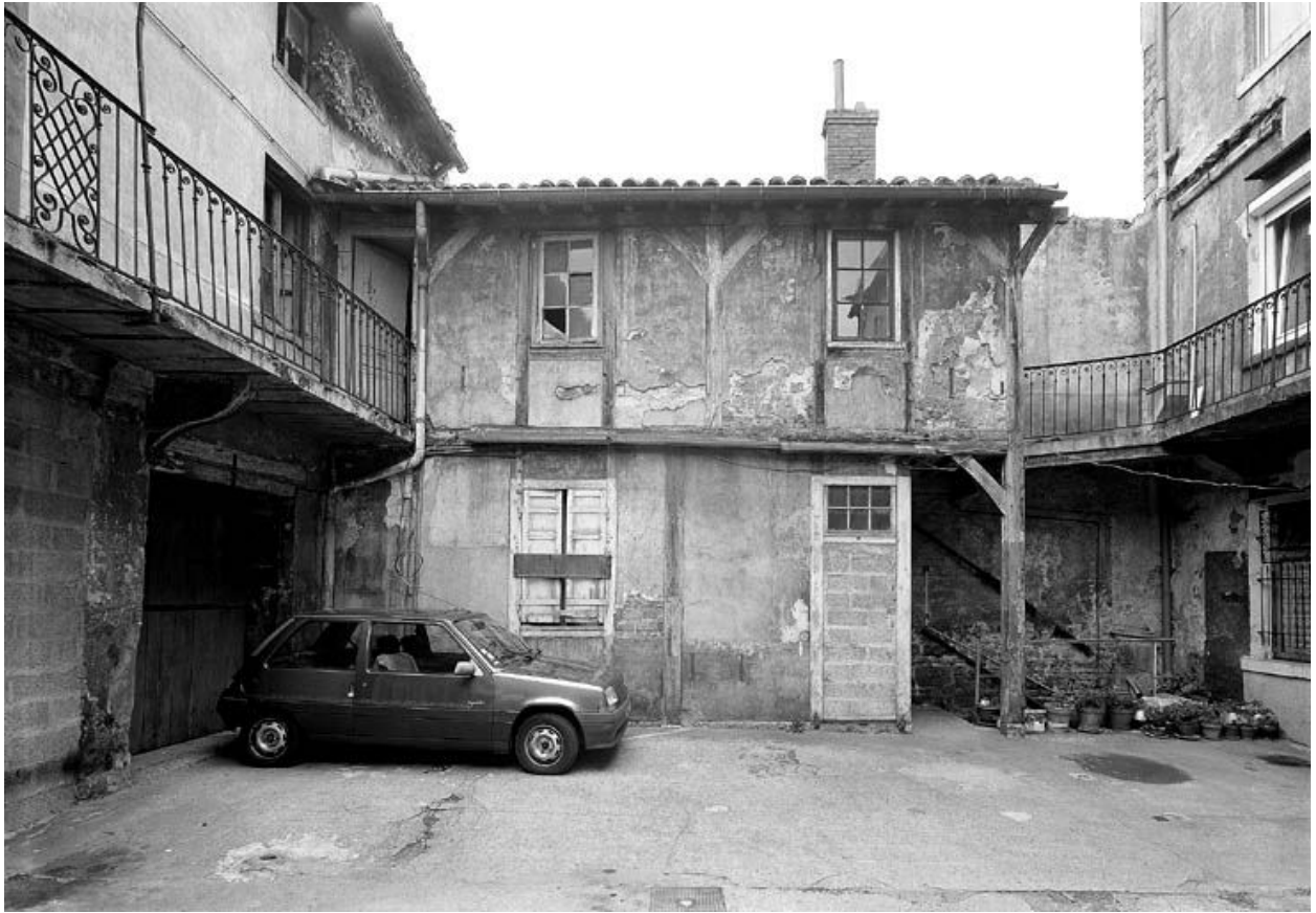
Corps de bâtiment reliant le corps de bâtiment sur rue et le corps de bâtiment sur cour, côté sud de la parcelle
