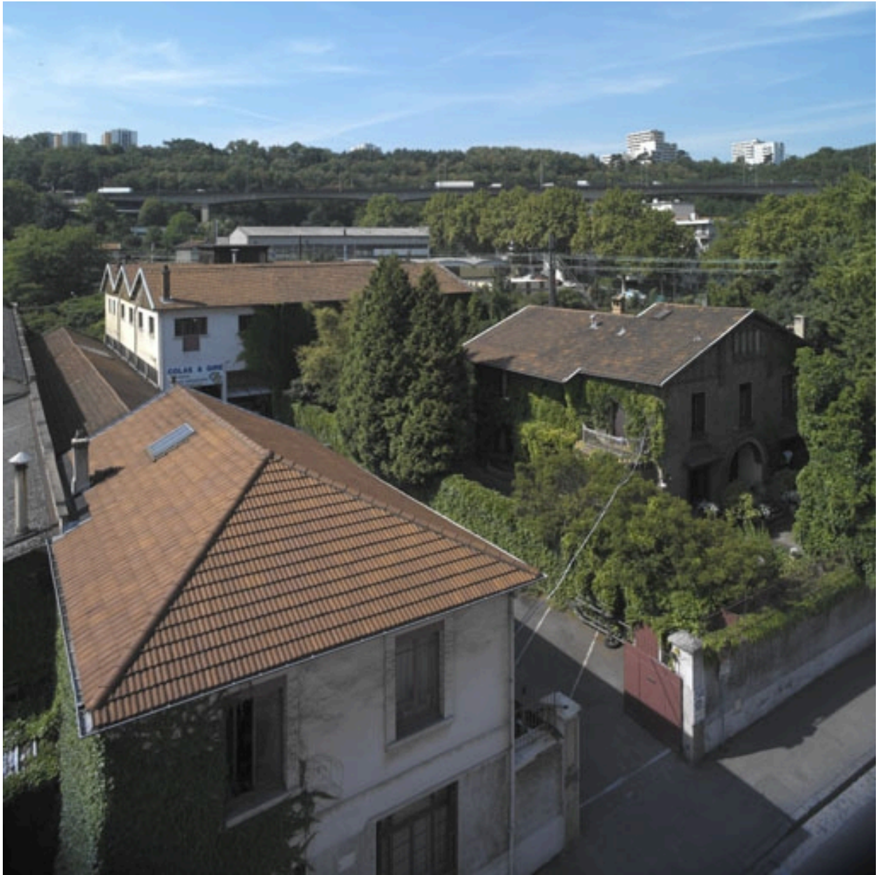
Vue générale sud-est : ateliers et maison patronale
