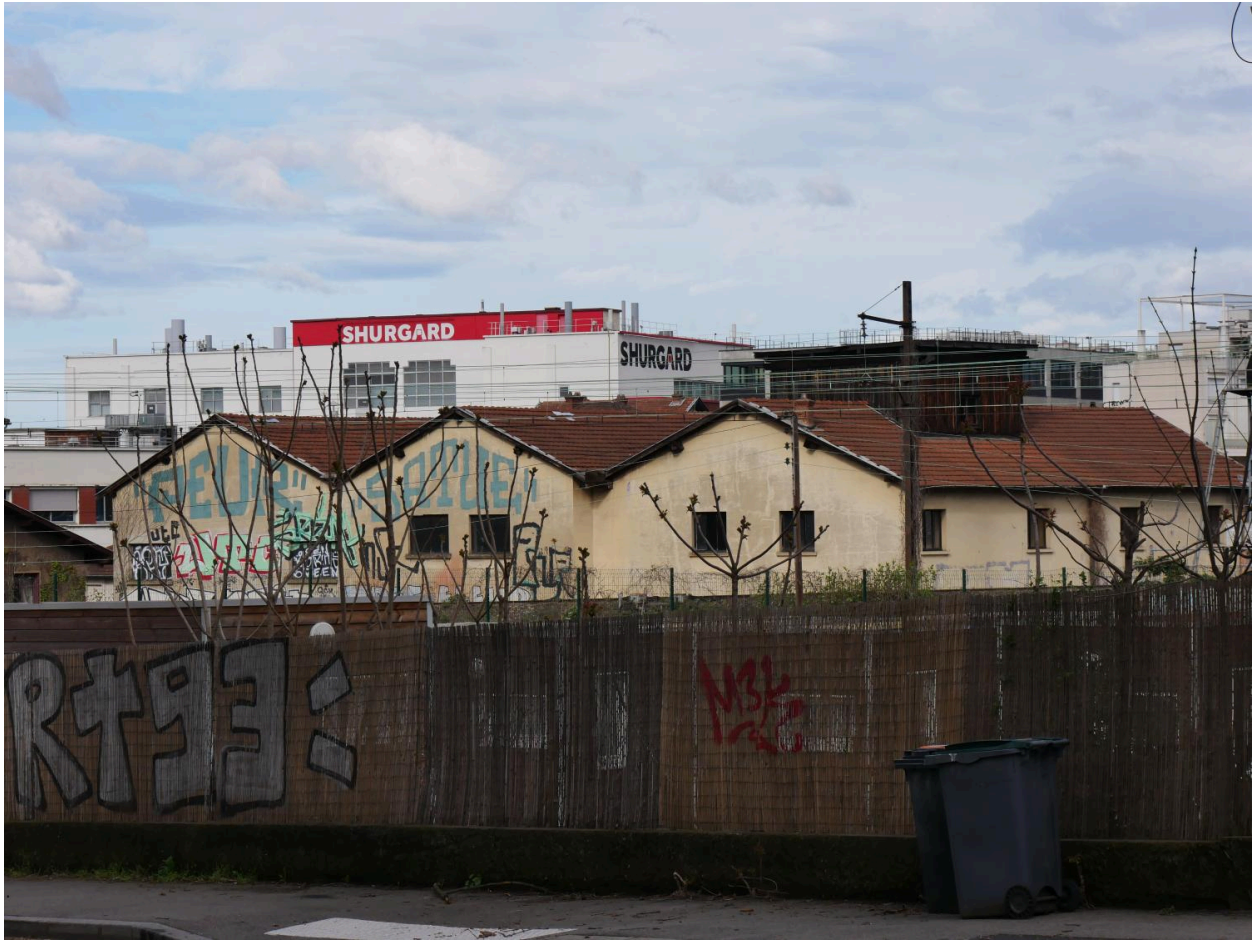
Vue des ateliers de l'usine Colas et Gire à Vaise
