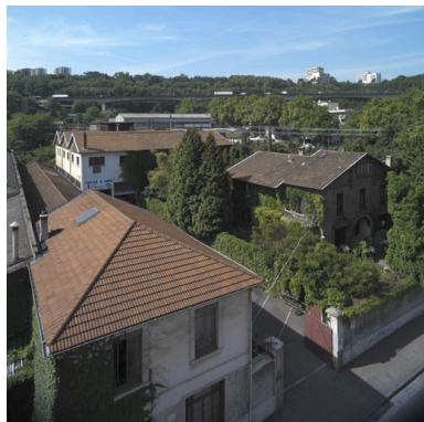
Vue générale sud-est : ateliers et maison patronale Phot. Eric Dessert IVR82_20036901647NUCA
