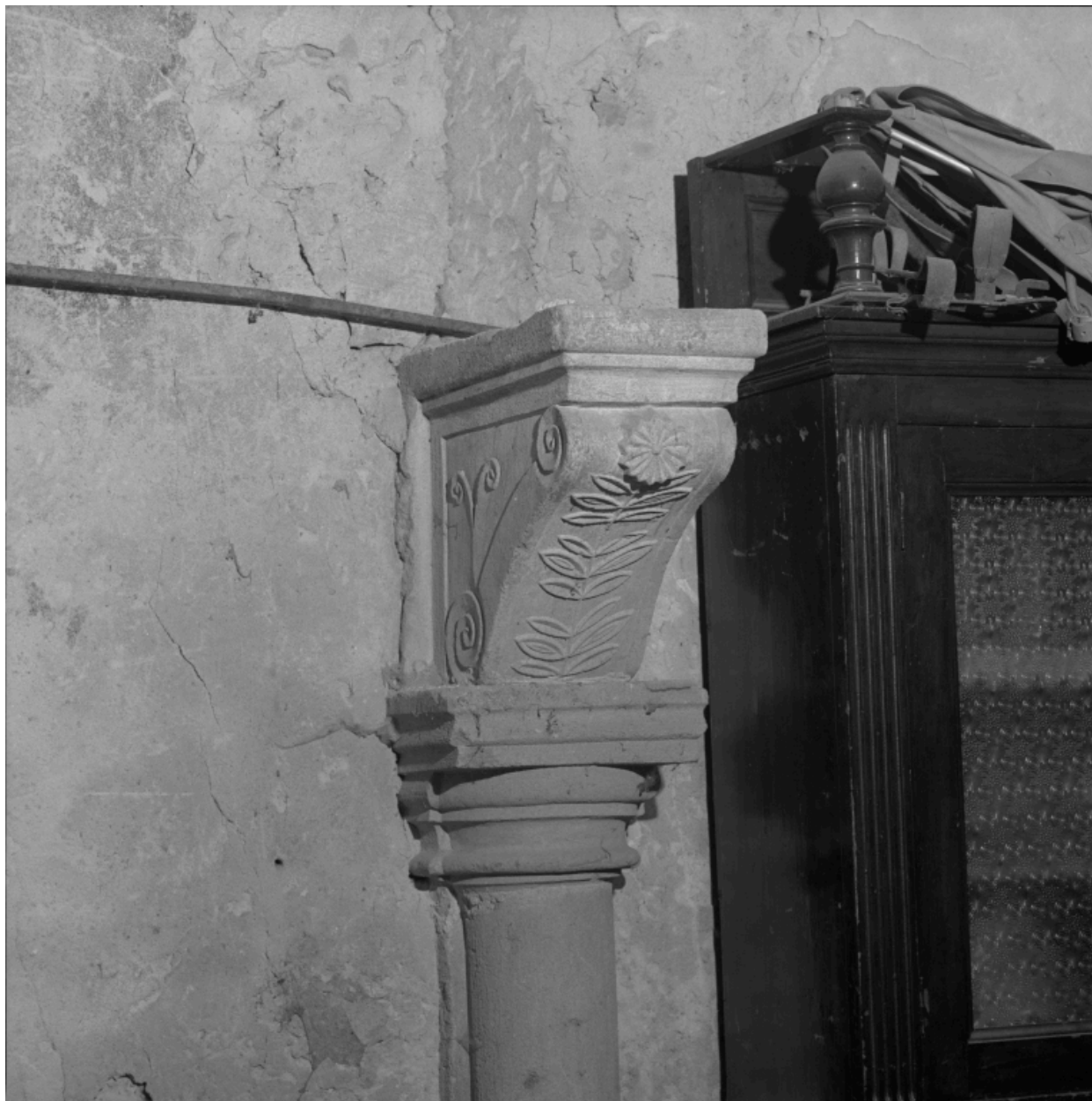
Aile droite, rez-de-chausée.
