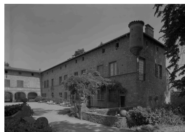
Aile droite; au premier plan, le ponceau sur le bief. Phot. Eric Dessert, Phot. Jean-Marie Refflé
