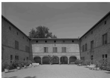
Vue partielle des élévations sur cour. Phot. Eric Dessert, Phot. Jean-Marie Refflé IVR82_19910100748P
