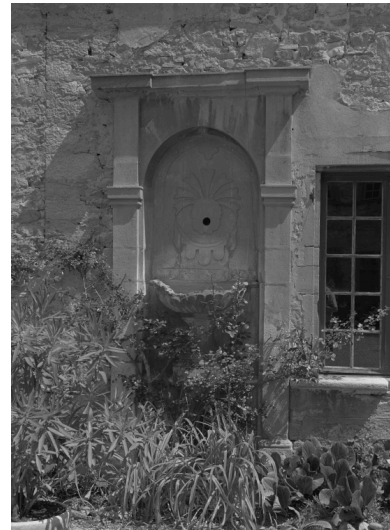
Fontaine adossée à l'aile droite, vestiges.
