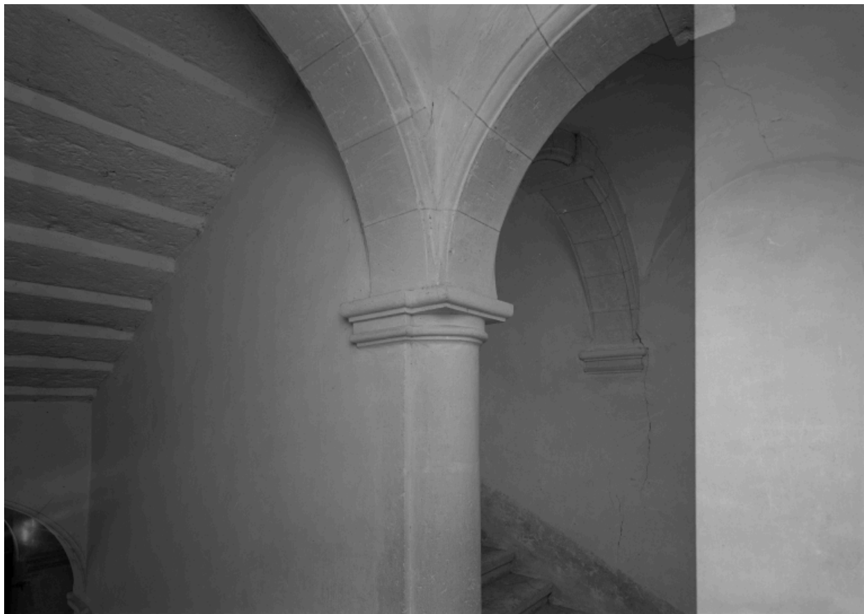
Escalier de l'aile gauche : couvrement au niveau du repos.
