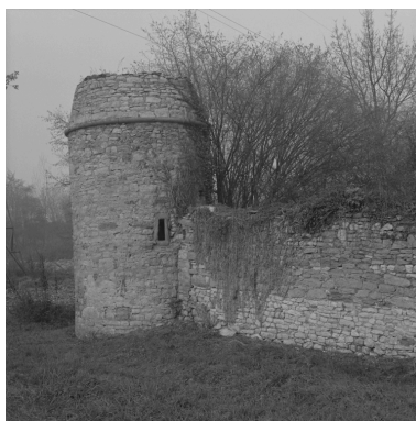
Tour d'angle du mur de clôture. Phot. Jean-Marie Refflé IVR82_19910100882X
