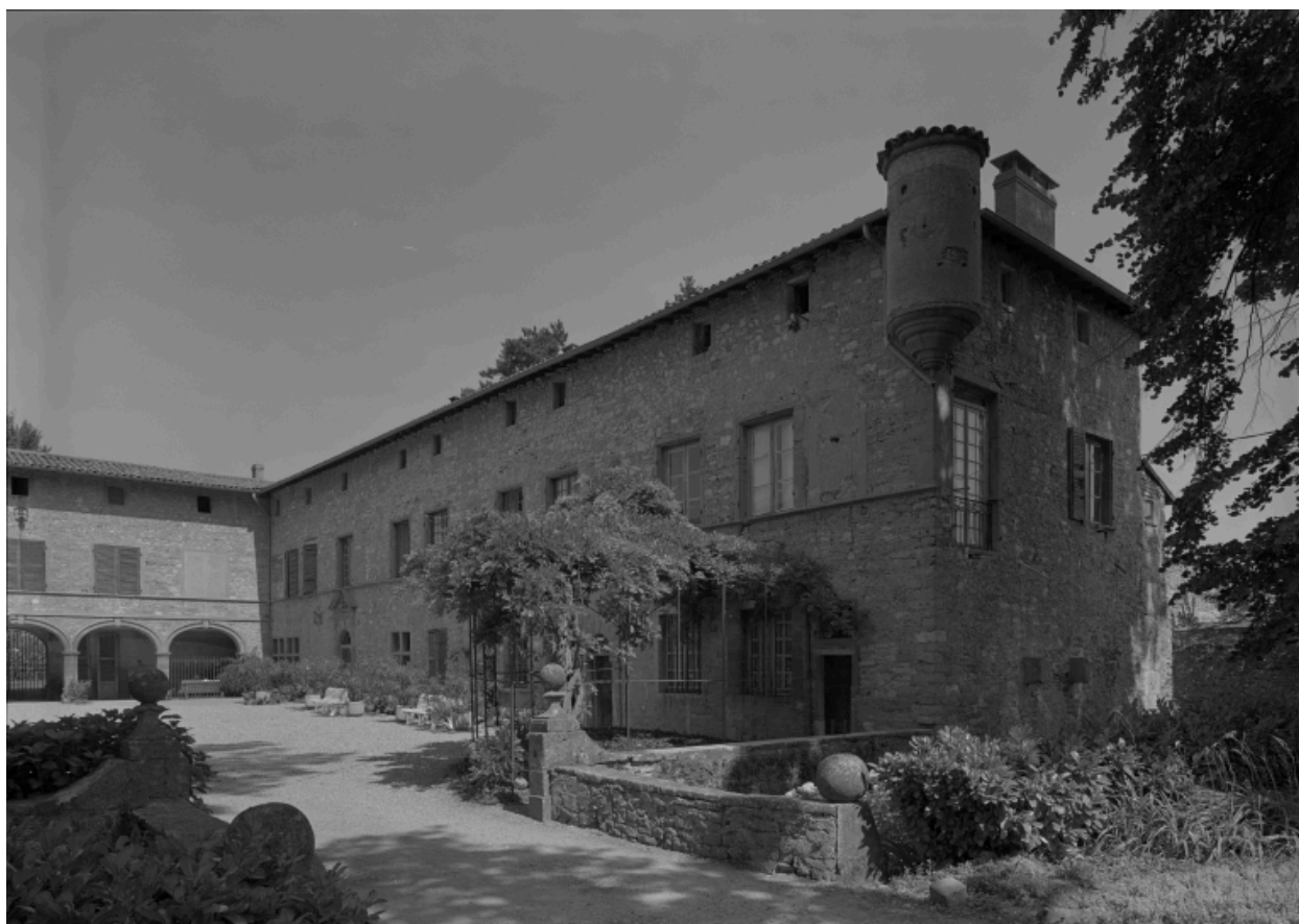
Aile droite; au premier plan, le ponceau sur le bief.
