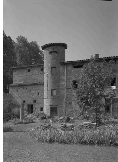
Aile droite, élévation postérieure, détail : partie gauche avancée, tour d'escalier hors-oeuvre à l'origine.
