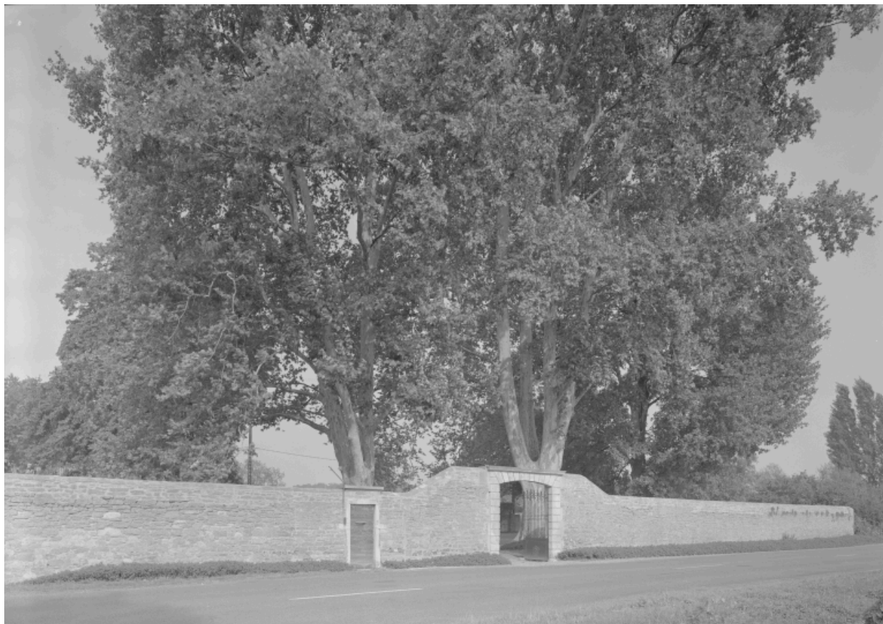
Mur de clôture et portail principal.
