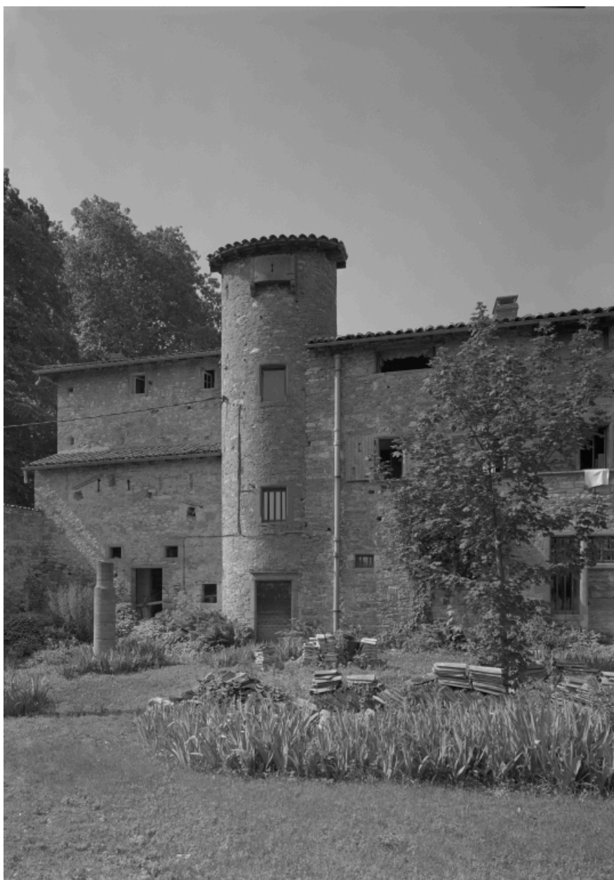
Aile droite, élévation postérieure, détail : partie gauche avancée, tour d'escalier hors-oeuvre à l'origine.
