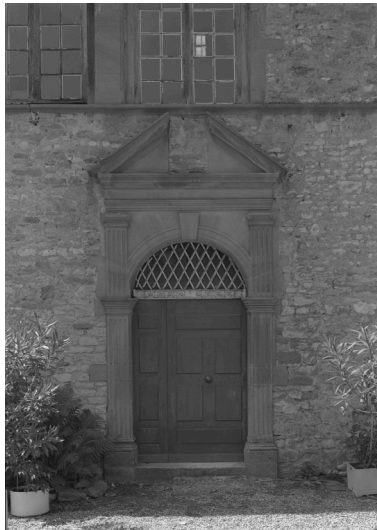
Porte d'entrée; ici celle de l'aile gauche.
