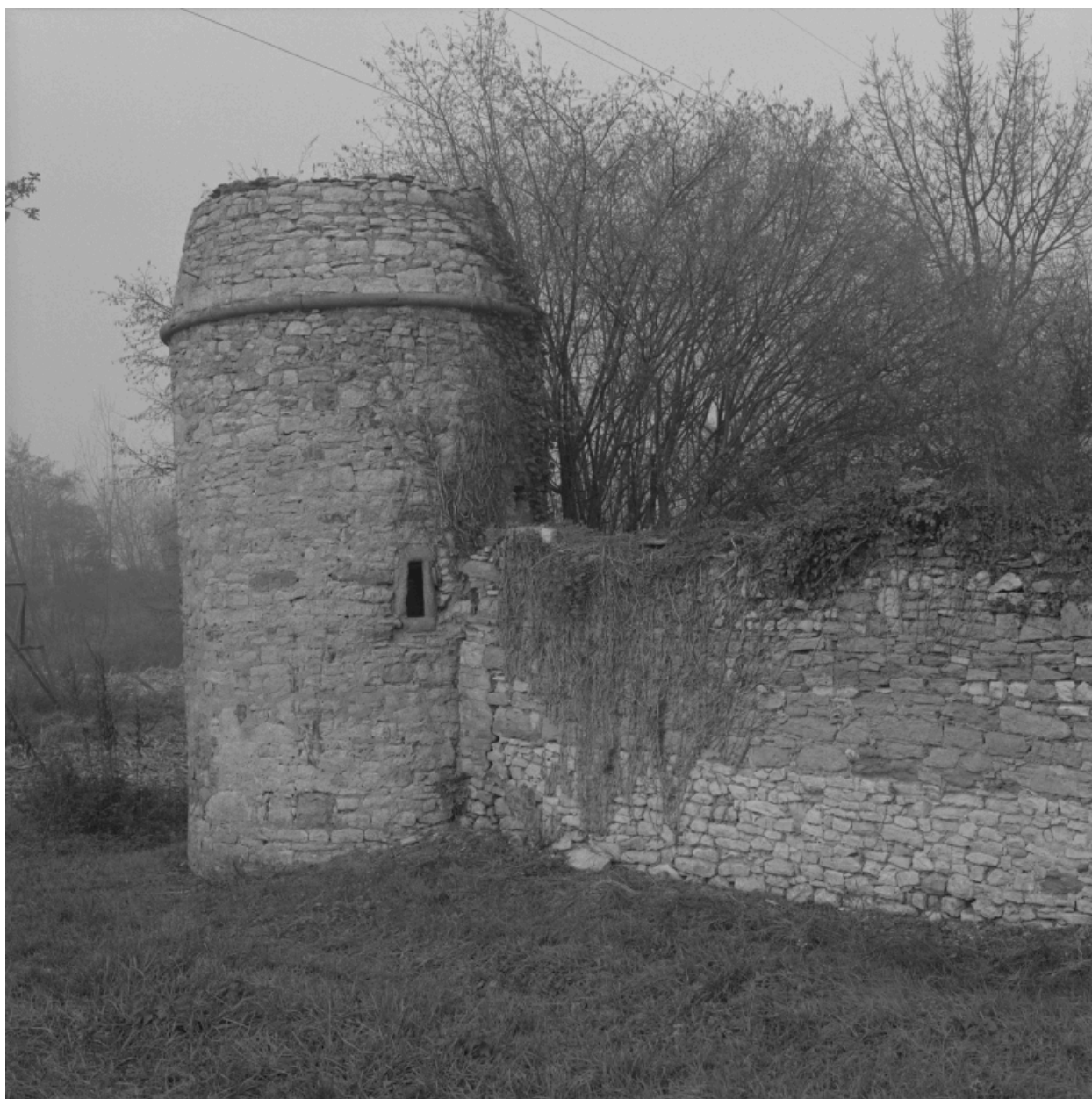
Tour d'angle du mur de clôture.
