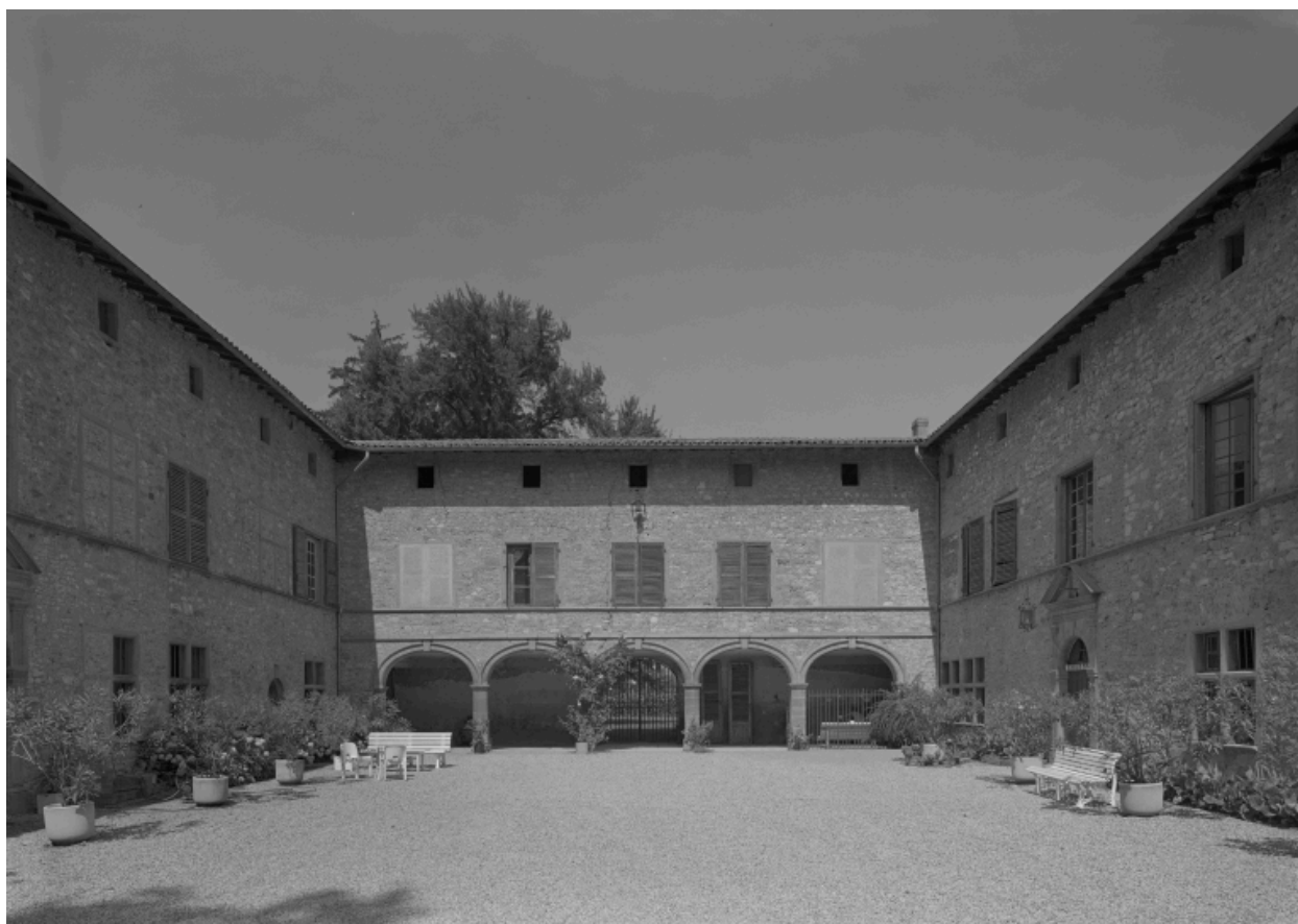
Vue partielle des élévations sur cour.
