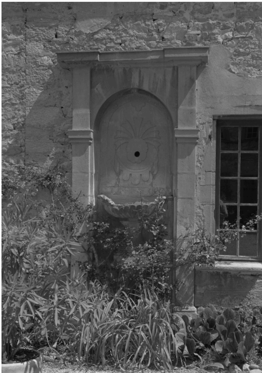
Fontaine adossée à l'aile droite, vestiges.
