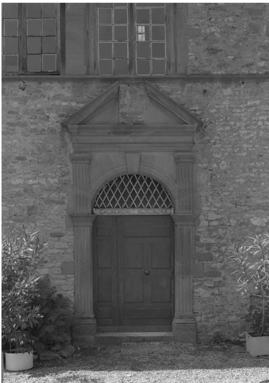
Porte d'entrée; ici celle de l'aile gauche.
