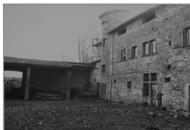
Château de Fétan. Hangar, aujourd'hui effondré. Repro. Jean-Marie Refflé IVR82_19960100094X
