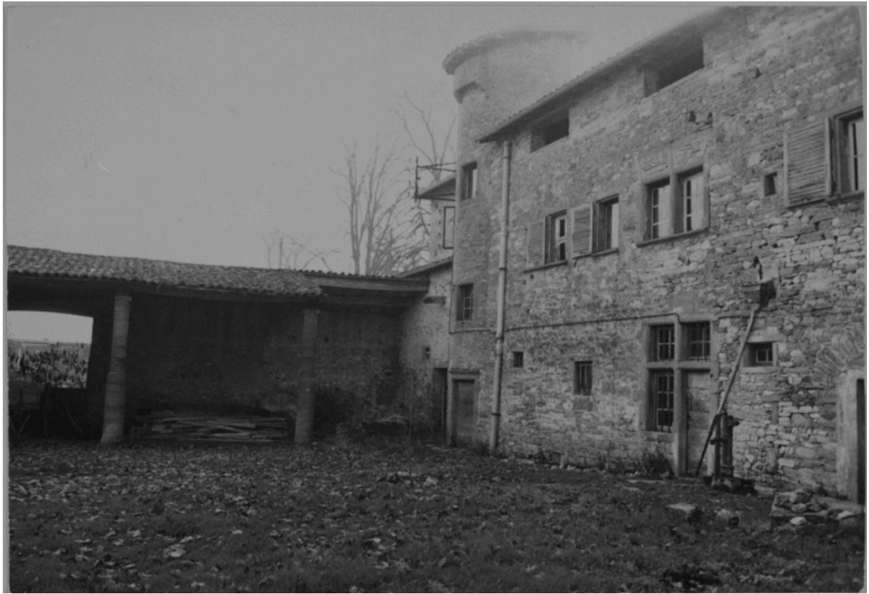
Château de Fétan. Hangar, aujourd'hui effondré.
