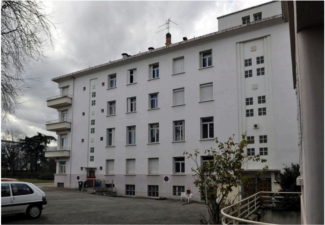
Aile sud, façade est
