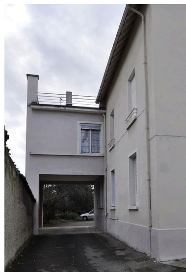
Façade nord, détail : construction surélevée. Phot. Julien Defillon IVR82_20106900914NUCA
