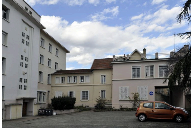
Façade sud (partie) Phot. Julien Defillon IVR82_20106900916NUCA
