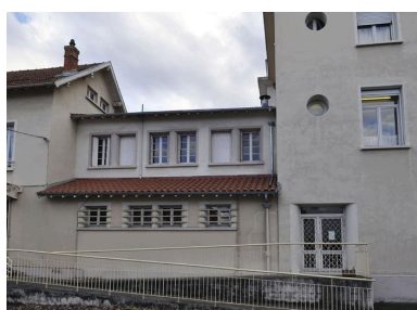
Façade nord, détail : adjonction des années 1930. Phot. Julien Defillon IVR82_20106900913NUCA
