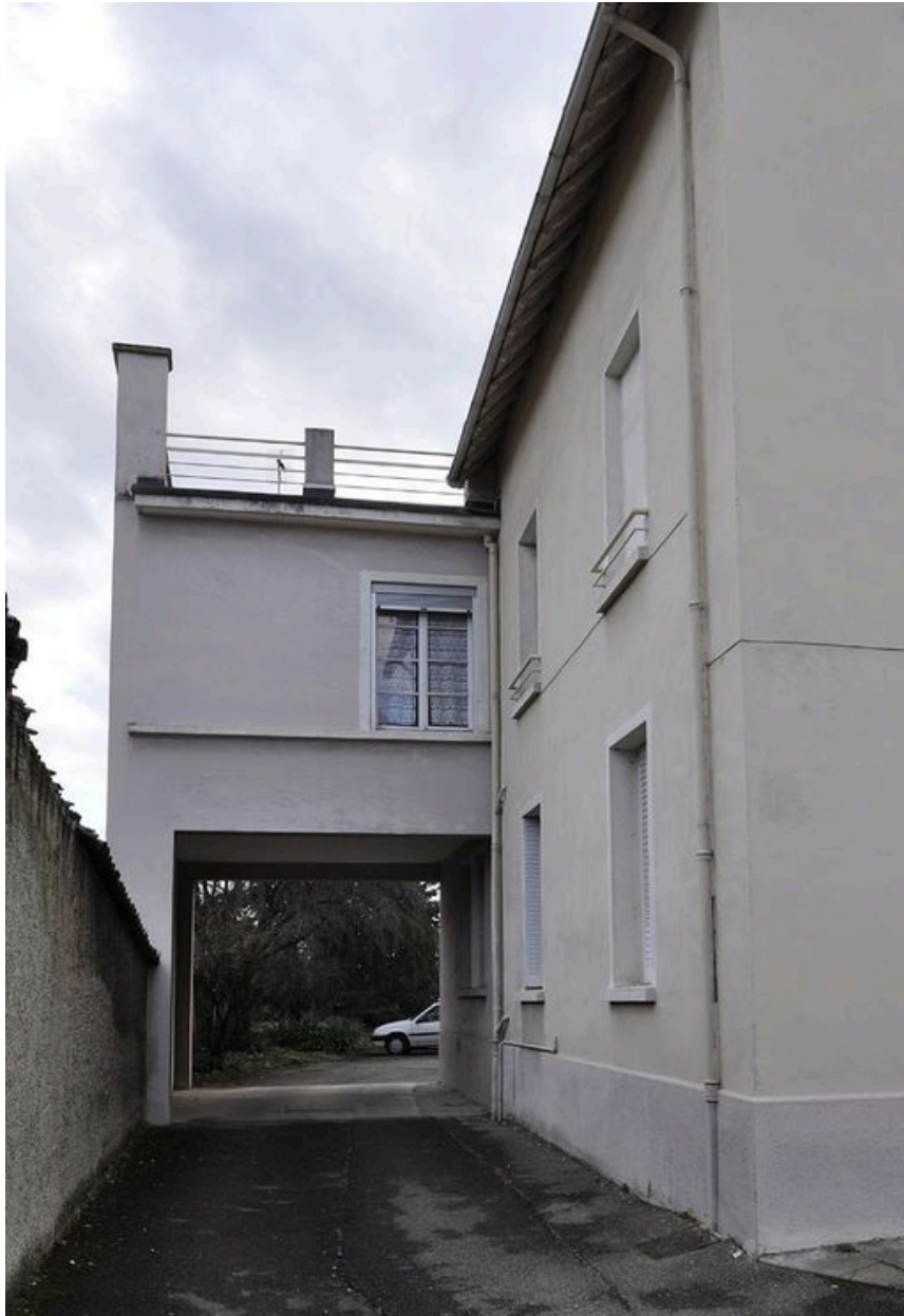
Façade nord, détail : construction surélevée.
