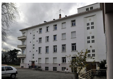
Aile sud, façade est Phot. Julien Defillon IVR82_20106900915NUCA
