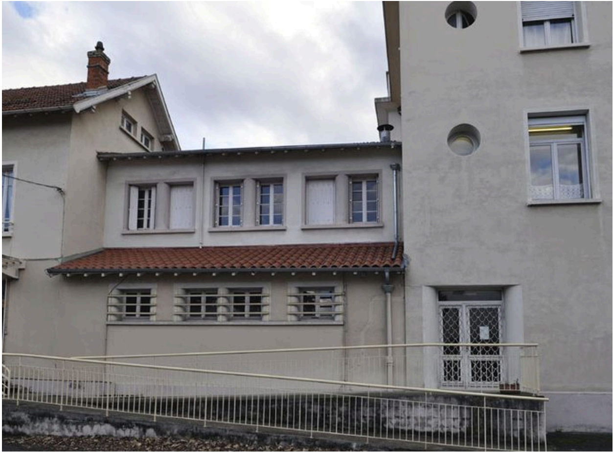
Façade nord, détail : adjonction des années 1930.
