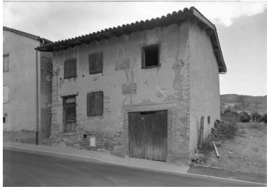
Vue d'ensemble de trois-quarts droite. Phot. Jean-Marie Refflé IVR82_20024200900P
