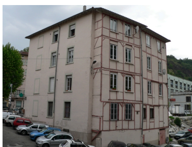
Façade arrière Phot. Isabelle Dupuis IVR82_20093800550NUCA
