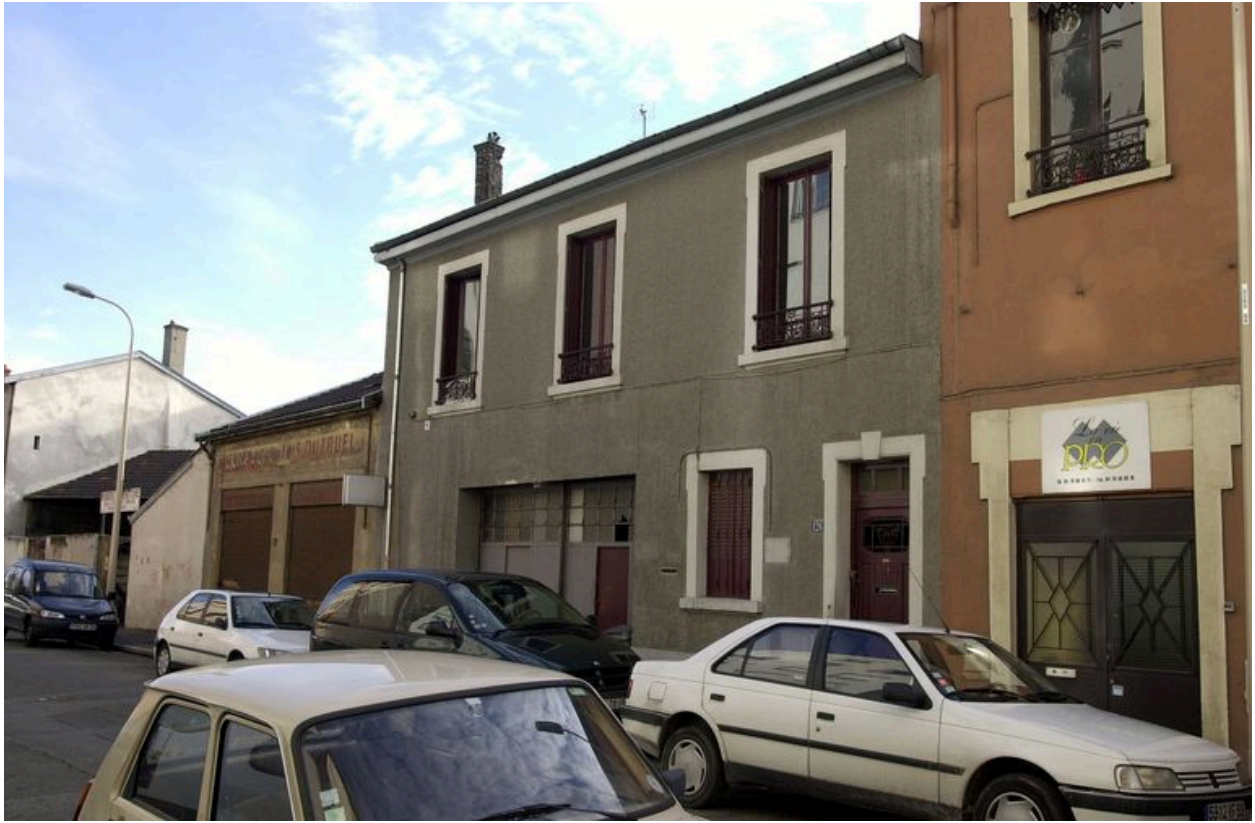
Vue de la façade principale, rue André-Bollier
