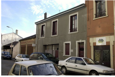
Vue de la façade principale, rue André-Bollier Phot. Bernard Ducouret IVR82_20016900169NUCA
