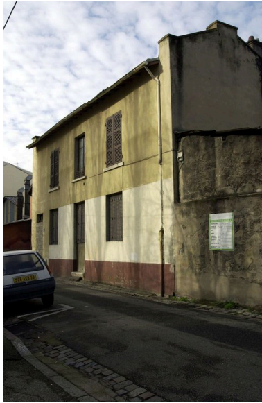
Vue de la façade postérieure, rue Hector-Malot Phot. Bernard Ducouret IVR82_20016900173NUCA
