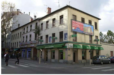
Vue de situation Phot. Bernard Ducouret IVR82_20026901558NUCA
