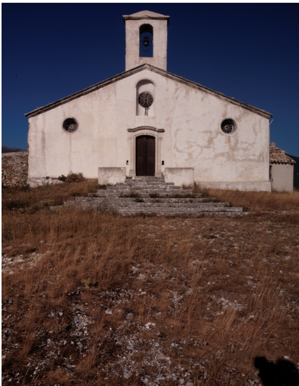
Façade, vue d'ensemble.
