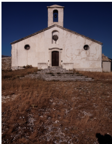
Façade, vue d'ensemble.
