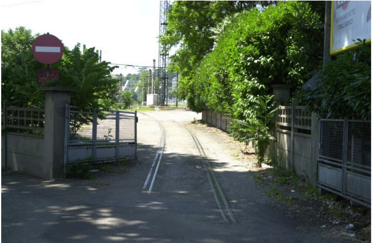
La voie ferrée reliant le marché de gros au réseau
