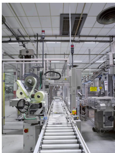
N°11 sur le plan de situation des prises de vue (voir plus haut). Atelier de confection-paquetage.
