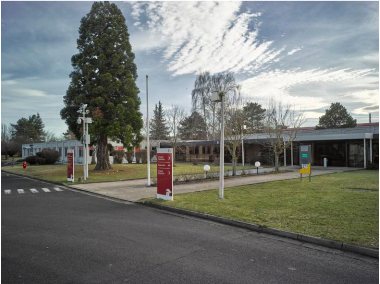
Façade principale (d'entrée), prise de l'angle nord-ouest.
