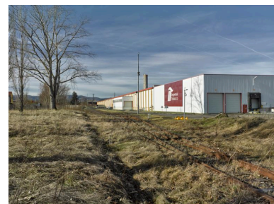
Vue générale depuis le sud-est, dans l'enclos de l'usine, avec embranchement ferroviaire au premier plan (à l'abandon depuis une dizaine d'années). Phot. Christian Parisey IVR84_20186300003NUC4A
