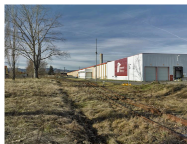
Vue générale depuis le sud-est, dans l'enclos de l'usine, avec embranchement ferroviaire au premier plan (à l'abandon depuis une dizaine d'années). Phot. Christian Parisey IVR84_20186300003NUC4A
