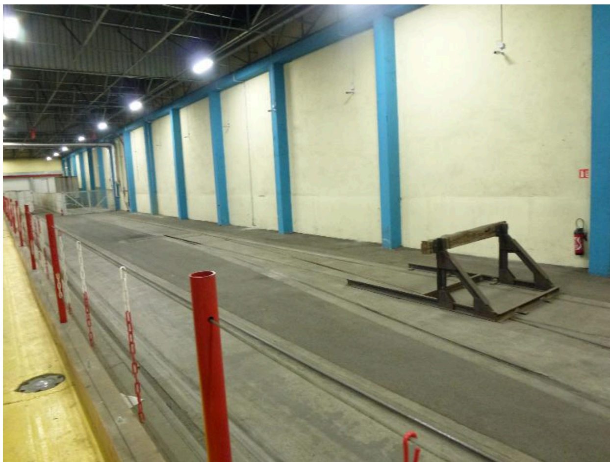
Butoir destiné à stopper la locomotive le long du quai de chargement (photo chercheur).
