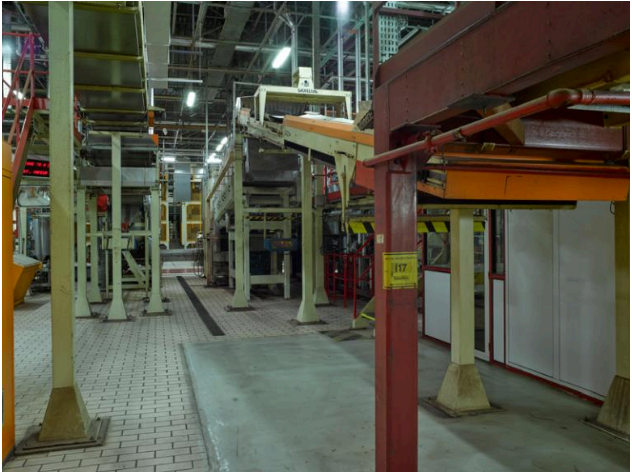
N°25 du plan de situation des prises de vue (voir plus haut). Injection de vapeur.
