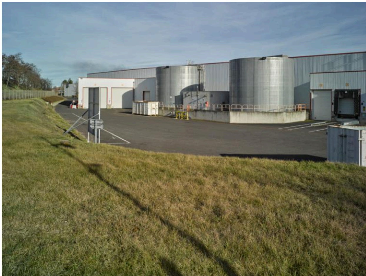
Élévation latérale ouest.
