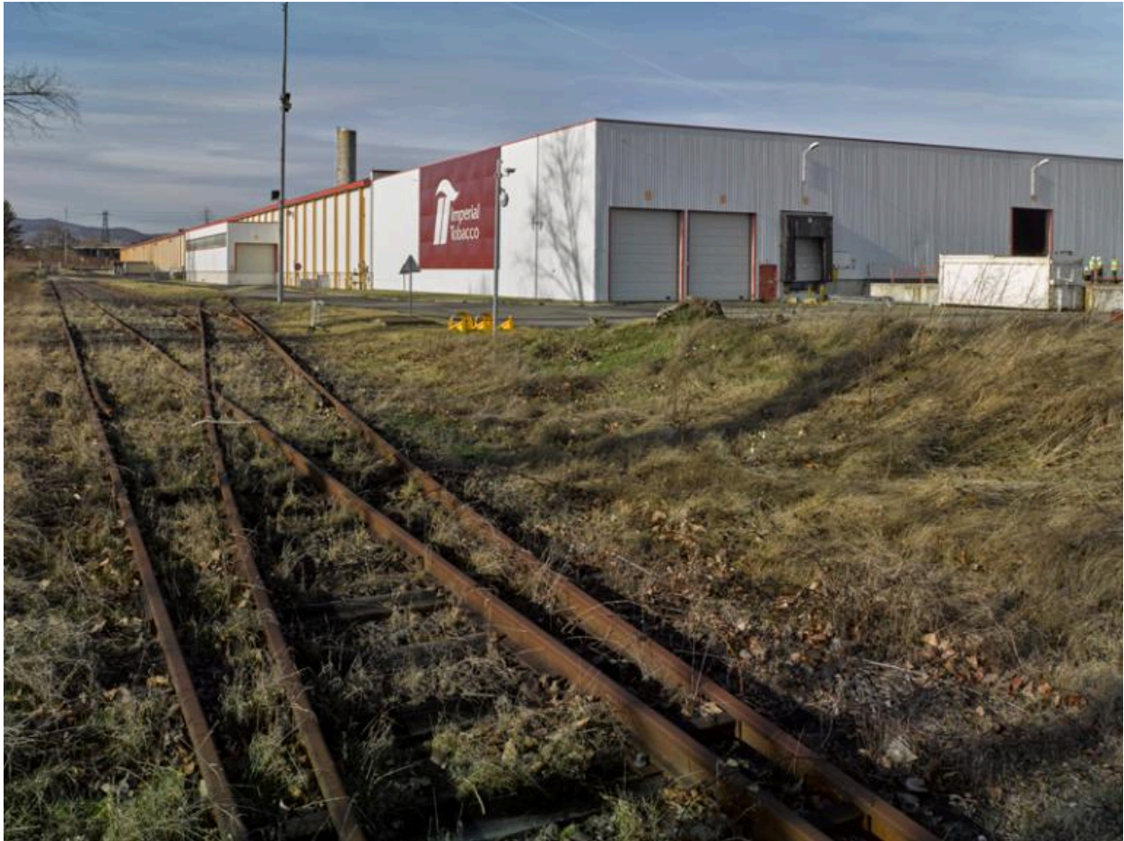
Vue générale prise du sud-est avec embranchement ferroviaire, désaffecté depuis une dizaine d'années, au premier plan.
