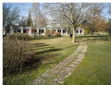
Bâtiment des bureaux, élévation est. Phot. Christian Parisey IVR84_20186300001NUC4A
