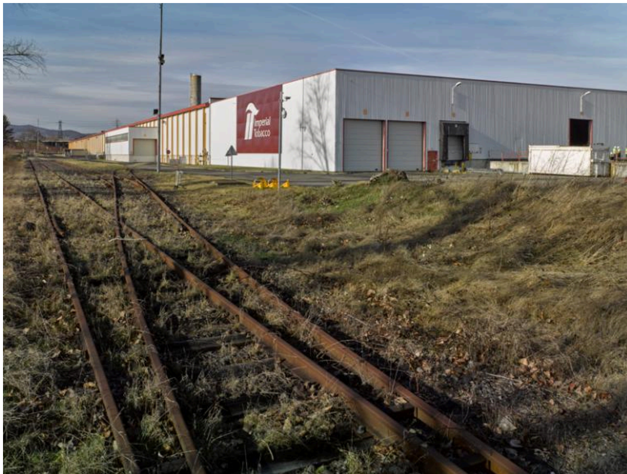
Vue générale prise du sud-est avec embranchement ferroviaire, désaffecté depuis une dizaine d'années, au premier plan.
