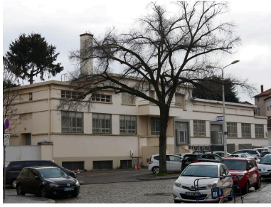
Vue d'ensemble des bains- douches de Saint-Just Phot. Nadine Halitim-Dubois IVR84_20226901533NUCA
