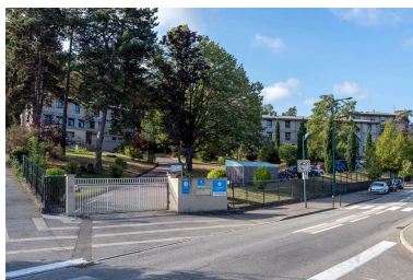
Vue d'ensemble. Phot. Michel Pérès IVR84_20200700050NUCA
