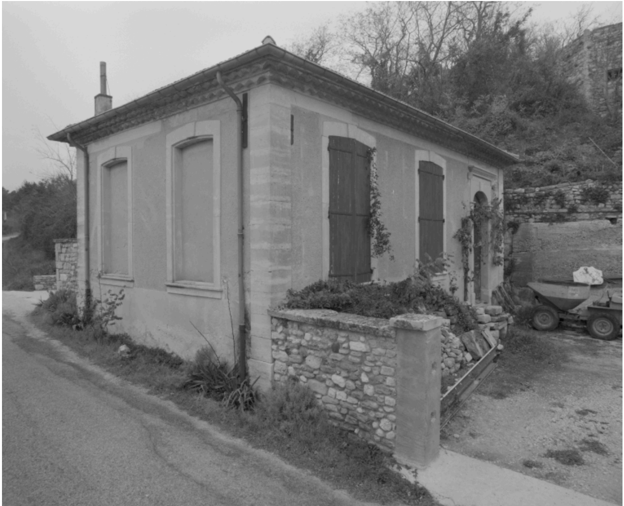
Vue de trois quarts de l'ancienne école des garçons, avant restauration.
