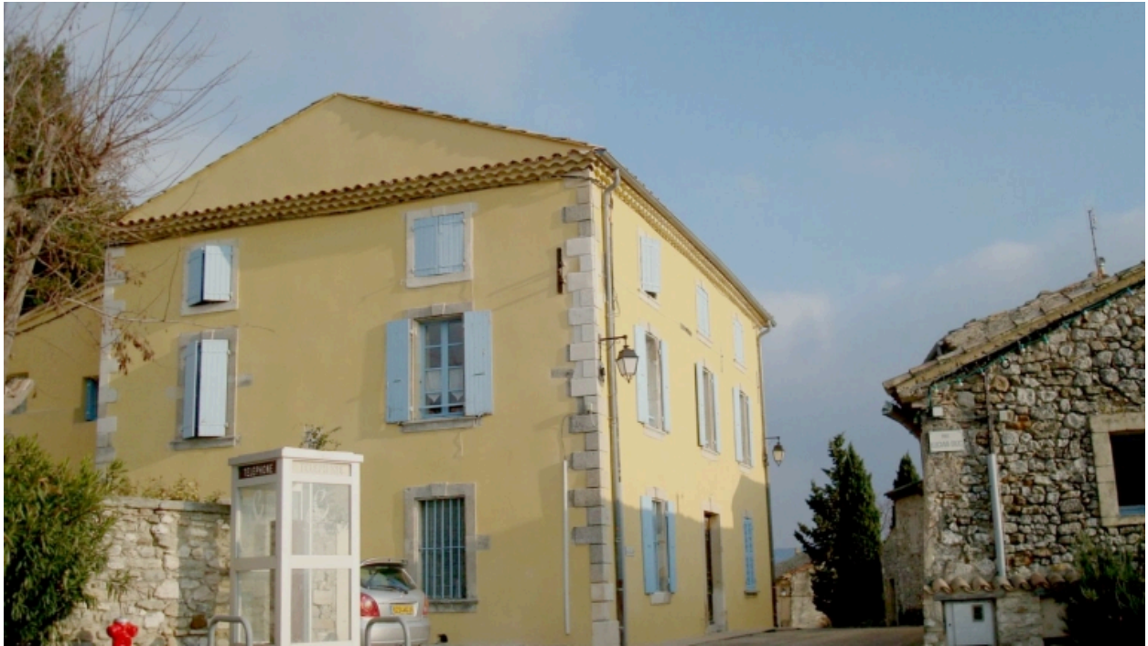
L'édifice restauré et converti en immeuble à appartements.
