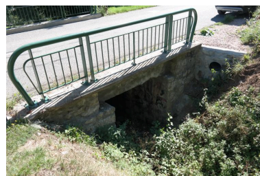
Pont du Borgel, vue de la face amont Phot. Pascale Renard IVR84_20207401506NUCA
