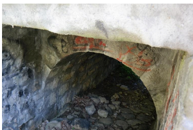
Pont du Borgel, détail de la voûte en face amont Phot. Pascale Renard IVR84_20207401508NUCA
