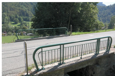
Pont du Borgel, vue de la chaussée et des garde-corps Phot. Pascale Renard IVR84_20207401507NUCA
