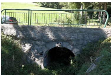
PONT du Borgel, vue de la face aval Phot. Pascale Renard IVR84_20197401234NUCA
