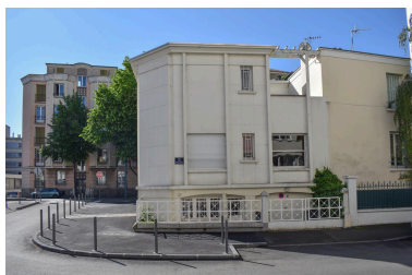
Au premier plan, l'élévation sur la rue des Prés-Bas; à l'arrière-plan la façade de l'immeuble Vigneron sur le boulevard Cote-Blatin Phot. Félicie Fougère IVR84_20246301294NUCA
