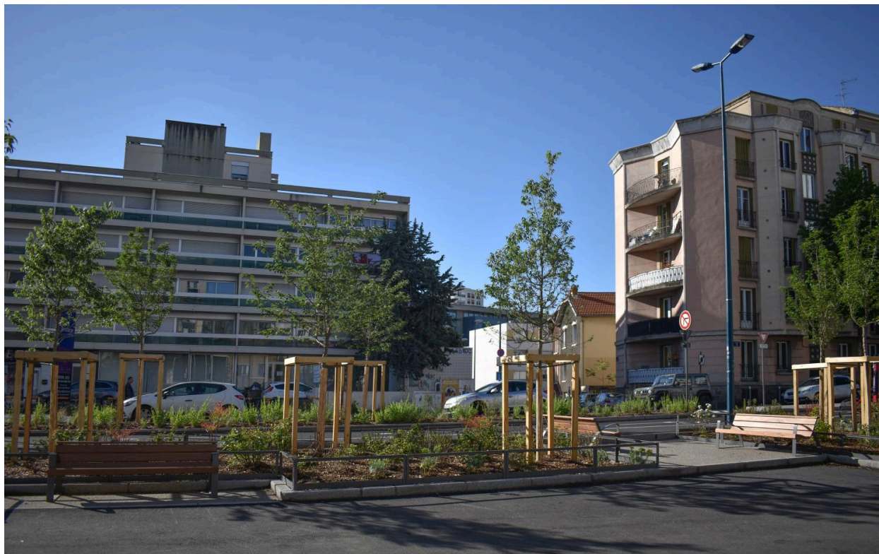
Immeuble Vigneron à l'angle du boulevard Cote-Blatin et de la rue Philippe-Glangeau; immeuble en retrait sur la place du débouché de la rue des Prés-Bas
