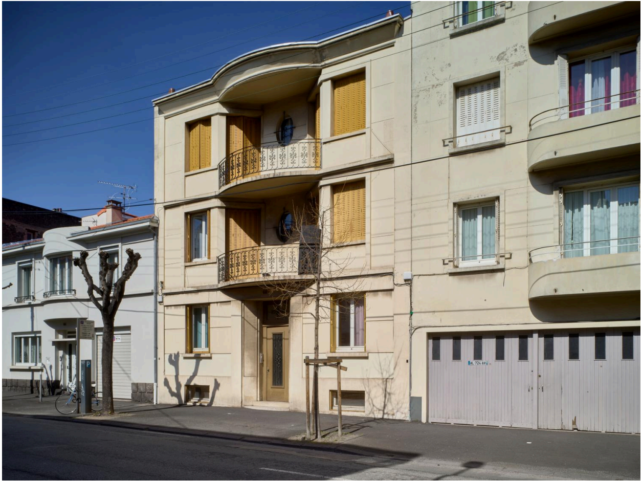
Façade sur le boulevard Jean-Jaurès
