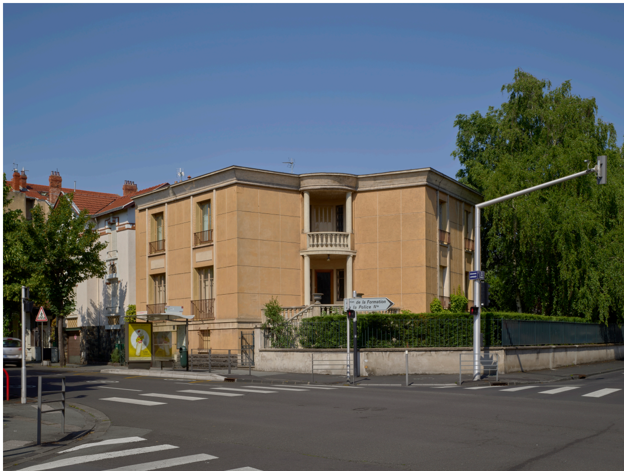
Vue de l'élévation principale depuis le carrefour du boulevard Lavoisier et de la rue Paul Diomède
