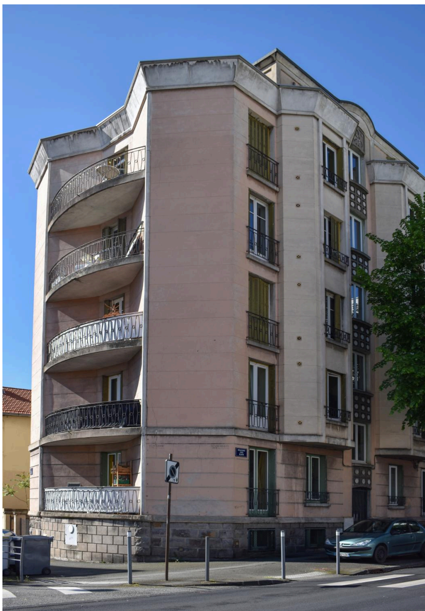
Travée d'angle, retrait aménagé en balcons
