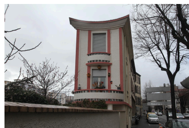
Elévation latérale au boulevard Phot. François-Nicolas L'Hardy IVR84_20246301014NUCA
