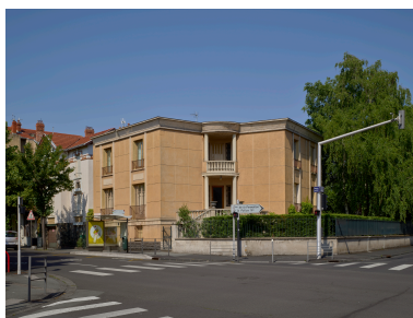
Vue de l'élévation principale depuis le carrefour du boulevard Lavoisier et de la rue Paul Diomède Phot. Christian Parisey IVR84_20236300504NUC4A
