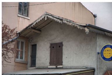
Partie supérieure de l'élévation antérieure Phot. Catherine Guégan IVR82_20086900132NUCA
