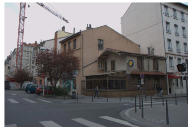
Elévations antérieure et latérale depuis le sud-est Phot. Catherine Guégan IVR82_20086900131NUCA
