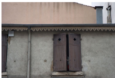
Détail de l'élévation latérale Phot. Catherine Guégan IVR82_20086900133NUCA
