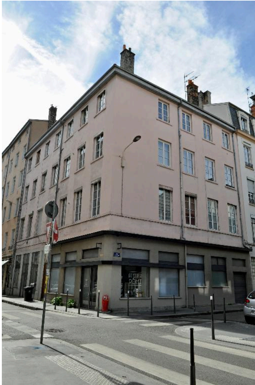
Vue générale, depuis le nord-ouest
