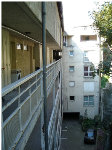
Coursives à l'arrière Phot. Isabelle Dupuis IVR82_20093800747NUCA
