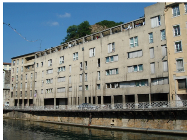
Vue générale Phot. Isabelle Dupuis IVR82_20093800746NUCA
