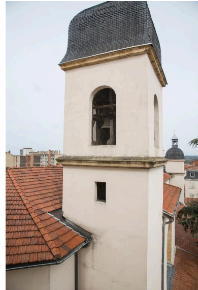
Clocher depuis la toiture. Phot. Pascal Lemaître IVR82_20134202419NUCA
