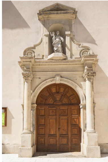
La porte d'entrée. Phot. Pascal Lemaître IVR82_20134202418NUCA
