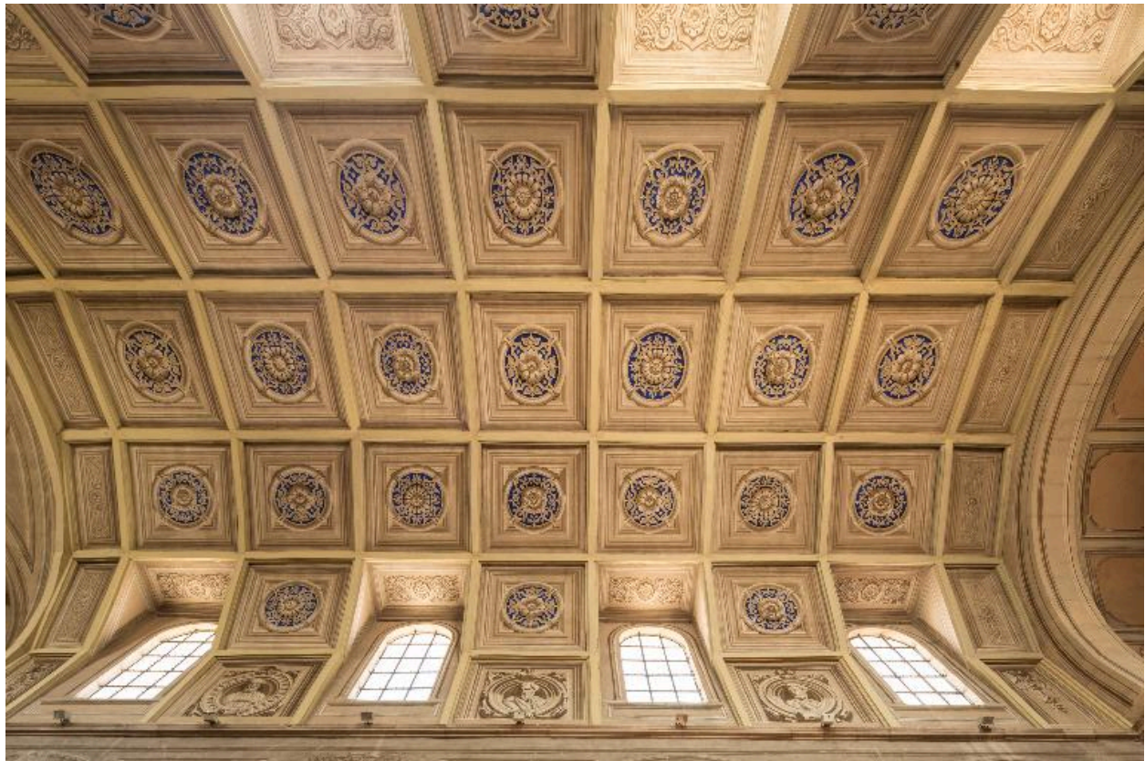
Voûte à caissons en bois.
