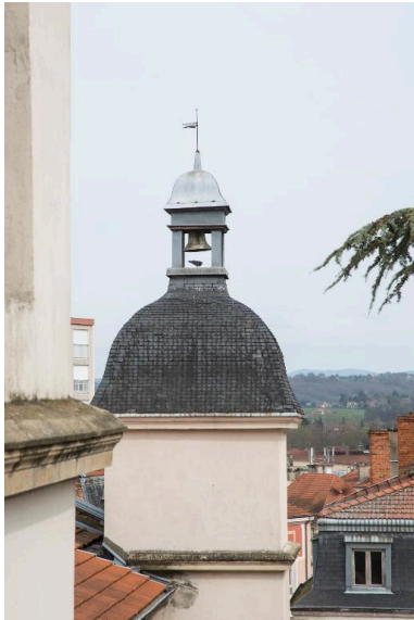
Clocher depuis la toiture. Phot. Pascal Lemaître IVR82_20134202420NUCA
