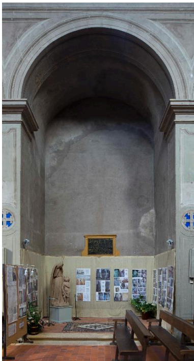
Chapelle actuelle de l'Ange gardien, bas-côté sud. Phot. Pascal Lemaître IVR82_20134202493NUCA
