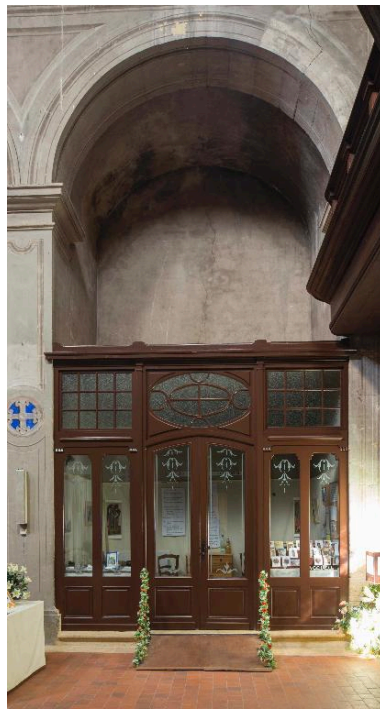
Bas-côté sud. Chapelle d'hiver. Phot. Pascal Lemaître IVR82_20134202495NUCA
