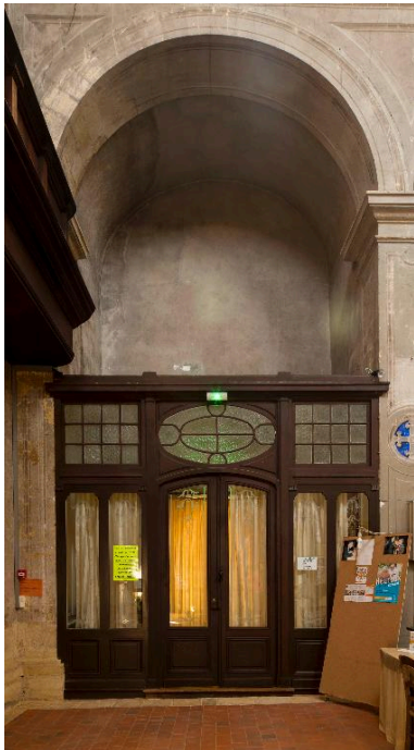
Bas-côté nord. Chapelle-sas "petit salon" ouvrant sur la galerie. Phot. Pascal Lemaître IVR82_20134202494NUCA
