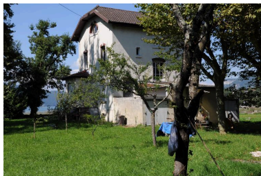
Vue d'ensemble : façade est et sud Phot. Denys Harreau IVR82_20157301032NUCA
