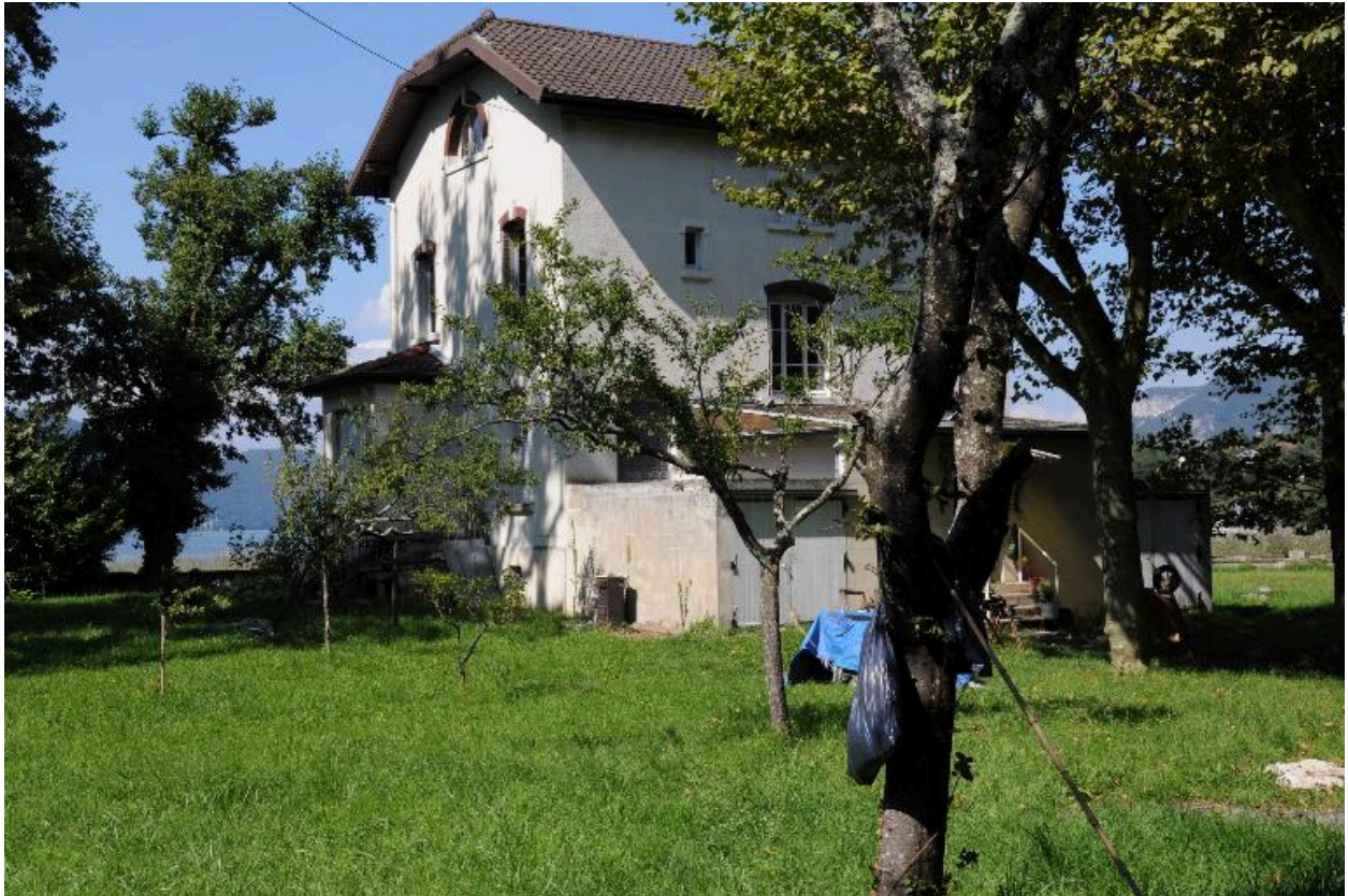
Vue d'ensemble : façade est et sud
