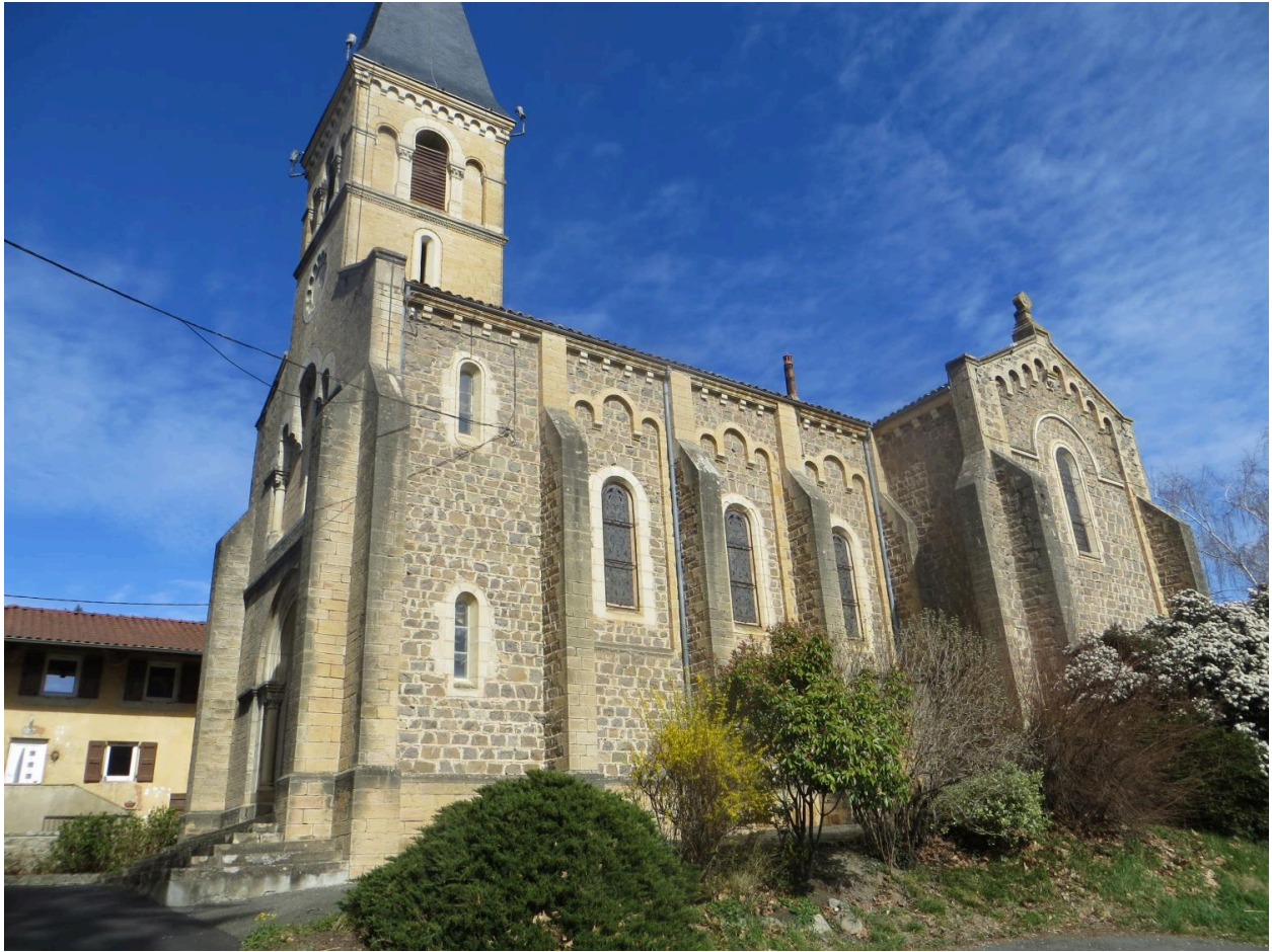
Elévation sud et clocher-porche
