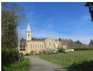
Vue de situation, élévation sud Phot. Véronique Belle IVR84_20236900391NUCA
