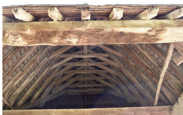
Charpente du auvent de la grange n°1 : vue générale Phot. Maryse Durin-Tercelin IVR84_20250300538NUCA
