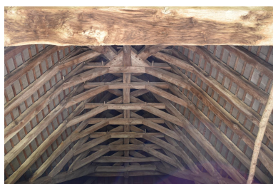
Charpente du auvent de la grange n°1 Phot. Maryse Durin-Tercelin IVR84_20250300536NUCA
