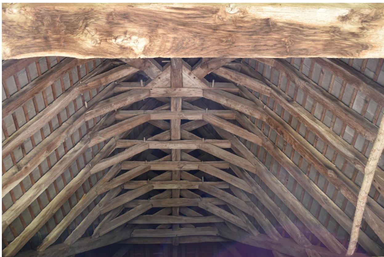
Charpente du auvent de la grange n°1
