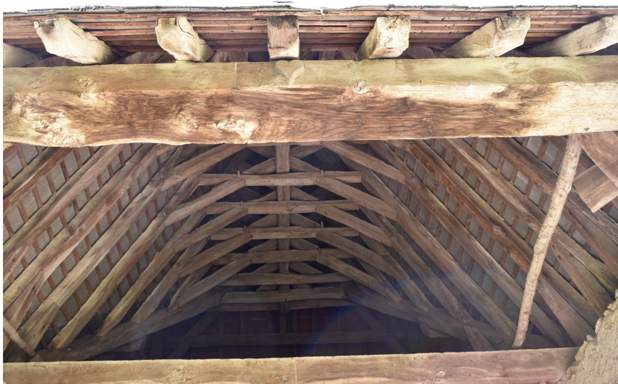
Charpente du auvent de la grange n°1 : vue générale
