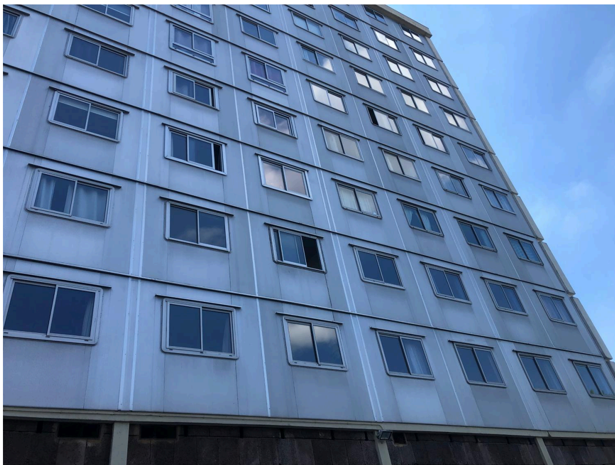
Façade nord de l'immeuble des Cèdres
