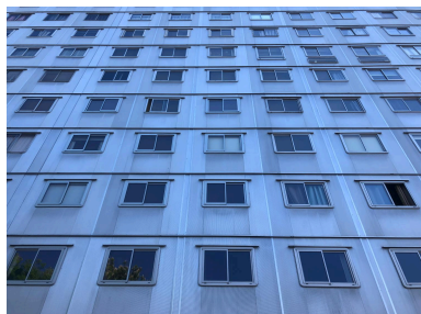
Façade nord de l'immeuble des Cèdres Phot. Léa Mauris-Demourieux IVR84_20256900720NUCA
