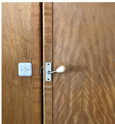
Détail Poignée d'origine Phot. Léa Mauris-Demourieux IVR84_20256900708NUCA
