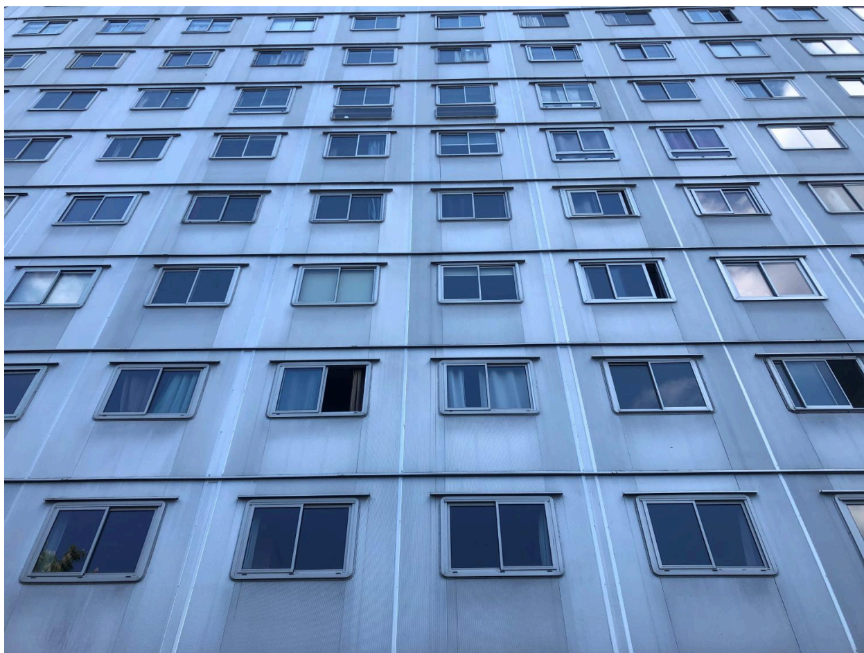
Façade nord (arrière de l'immeuble des Cèdres)
