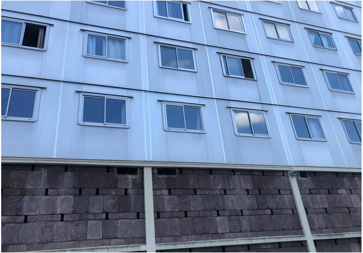
Façade nord et détail soubassement apparent
