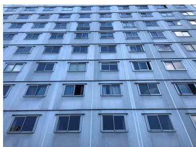
Façade nord (arrière de l'immeuble des Cèdres) Phot. Léa Mauris-Demourieux IVR84_20256900704NUCA
