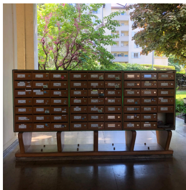
Boîtes aux lettres dans un ensemble menuisé élégant. Phot. Léa Mauris-Demourieux IVR84_20256900713NUCA
