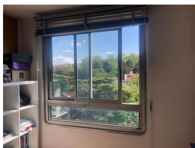
Menuiserie coulissante en aluminium aux angles arrondis Phot. Léa Mauris-Demourieux IVR84_20256900710NUCA
