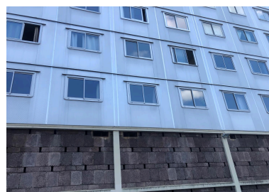
Façade nord et détail soubassement apparent Phot. Léa Mauris-Demourieux IVR84_20256900706NUCA
