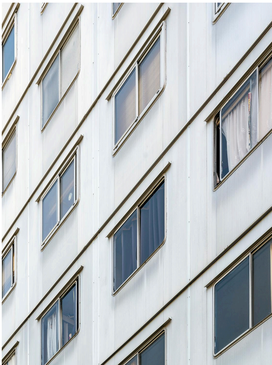
Façade nord de l'immeuble des Cèdres
