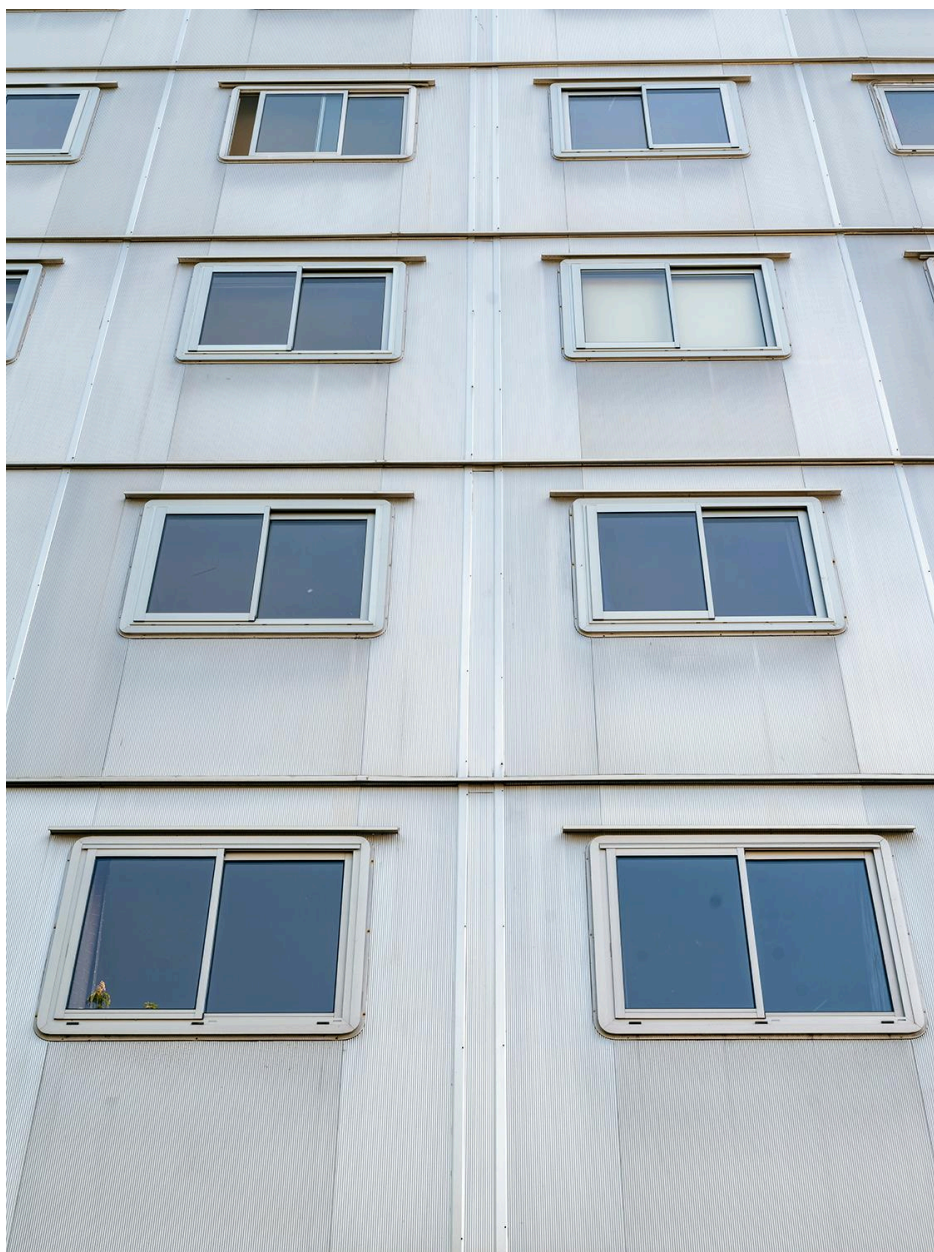
Façade nord de l'immeuble des Cèdres
