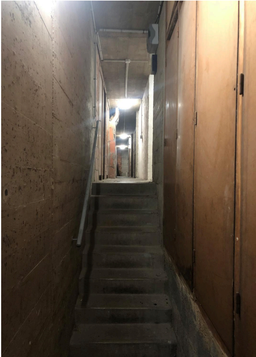
Accès aux caves : sous-sol des caves de l'immeuble
