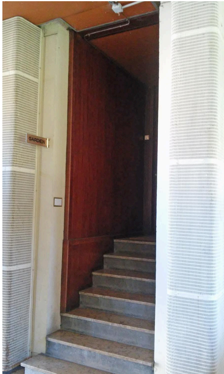
Loge du gardien au rez-de-chaussée
