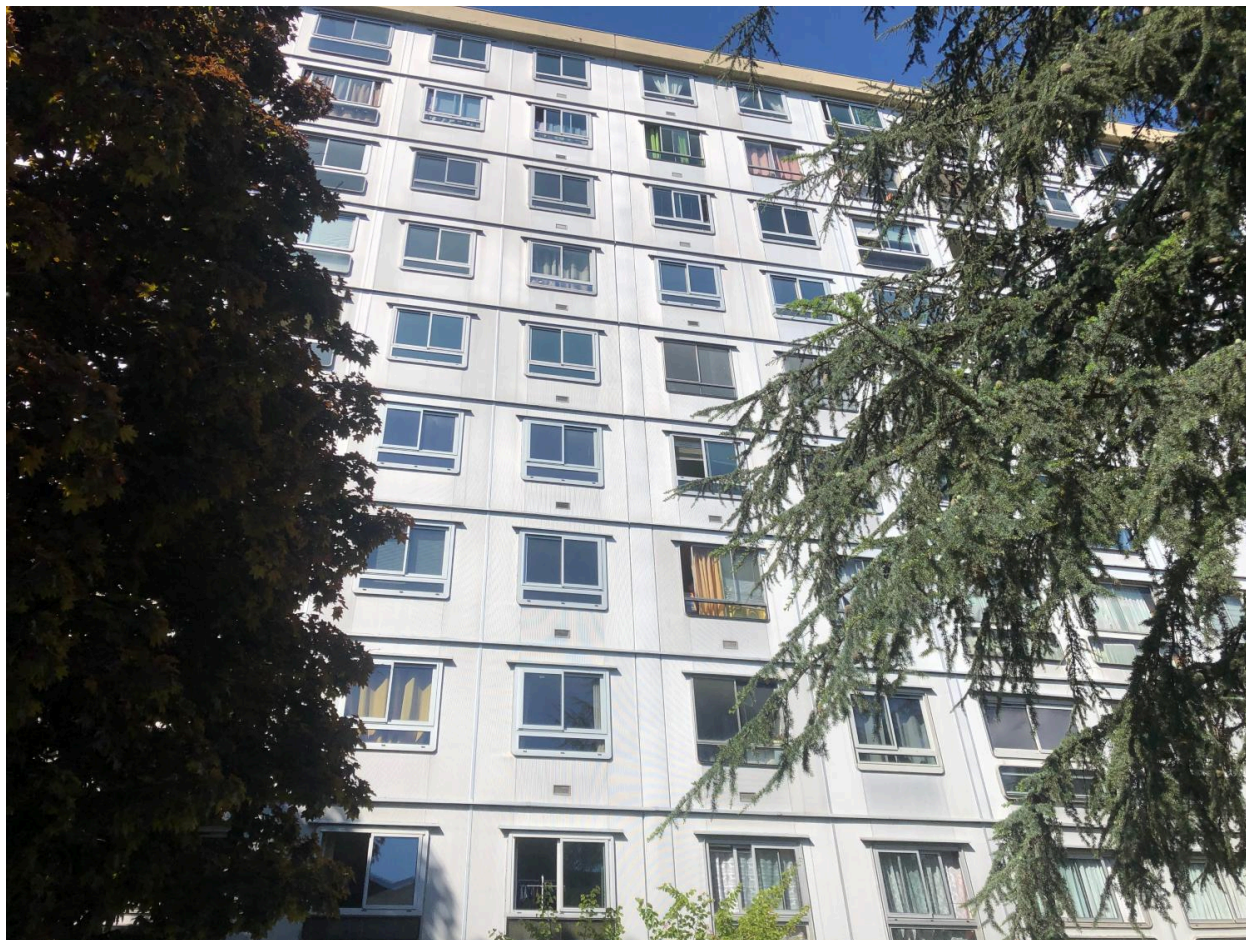
Façade principale (sud) de l'immeuble des Cèdres
