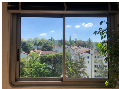
Menuiserie coulissante en aluminium aux angles arrondis Phot. Léa Mauris-Demourieux IVR84_20256900707NUCA
