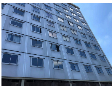
Façade nord de l'immeuble des Cèdres Phot. Léa Mauris-Demourieux IVR84_20256900705NUCA
