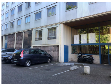
Façade nord, loge du gardien au rez-de-chaussée (2 baies) Phot. Léa Mauris-Demourieux IVR84_20256900721NUCA
