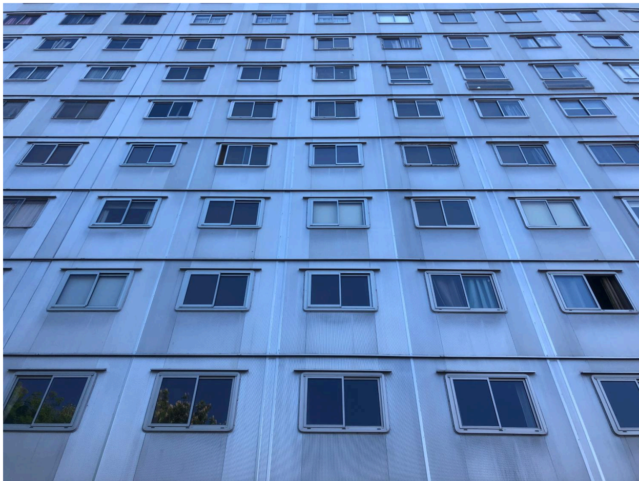
Façade nord de l'immeuble des Cèdres
