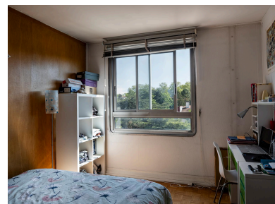
Fenêtre à menuiserie coulissante en aluminium aux angles arrondis Phot. Michel Pérès IVR84_20256900764NUCAQ
