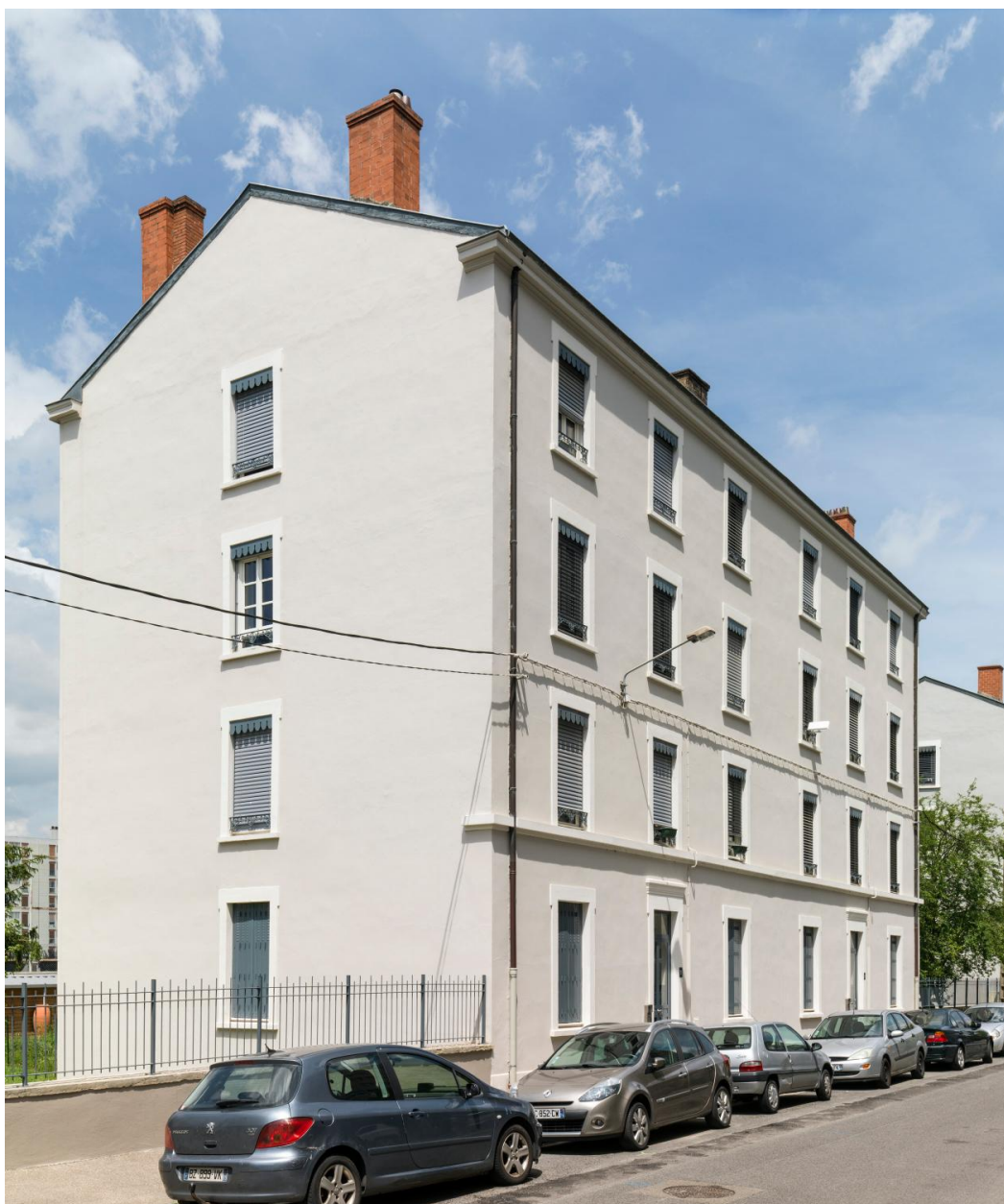
Détail pignon nord
