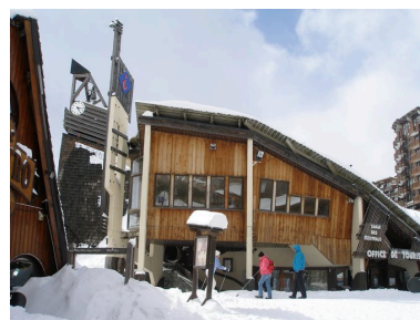
Vue d'ensemble, rue du Festival, depuis le sud-est Phot. Jean-François Lyon- Caen, Phot. C. Salomon-Pelen IVR82_20087400498NUCA
