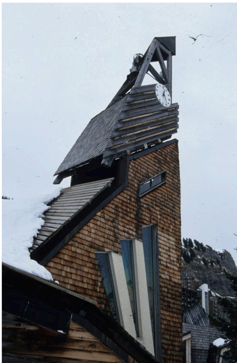
Détail du beffroi, depuis le sud-ouest
