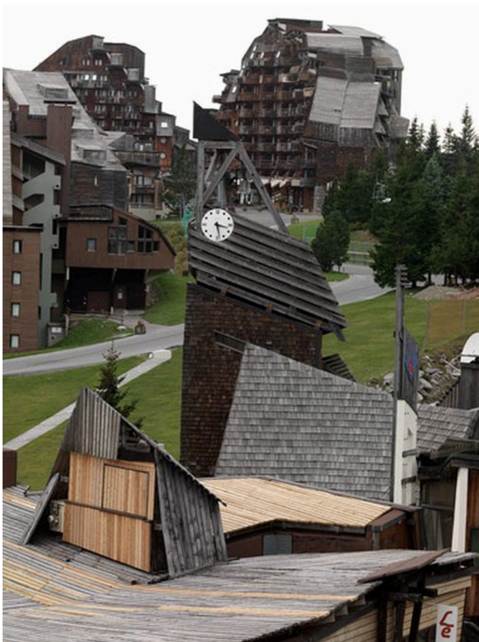
Détail du beffroi depuis le nord-est
