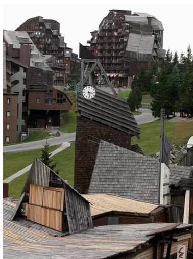
Détail du beffroi depuis le nord-est Phot. Eric Dessert IVR82_20097400690NUCA
