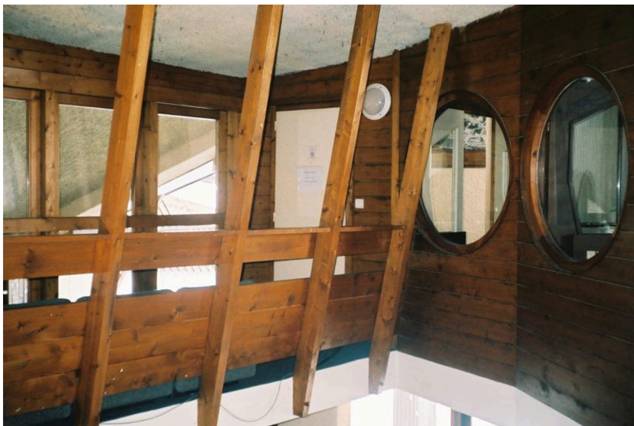
Détail du garde-corps à l'étage
