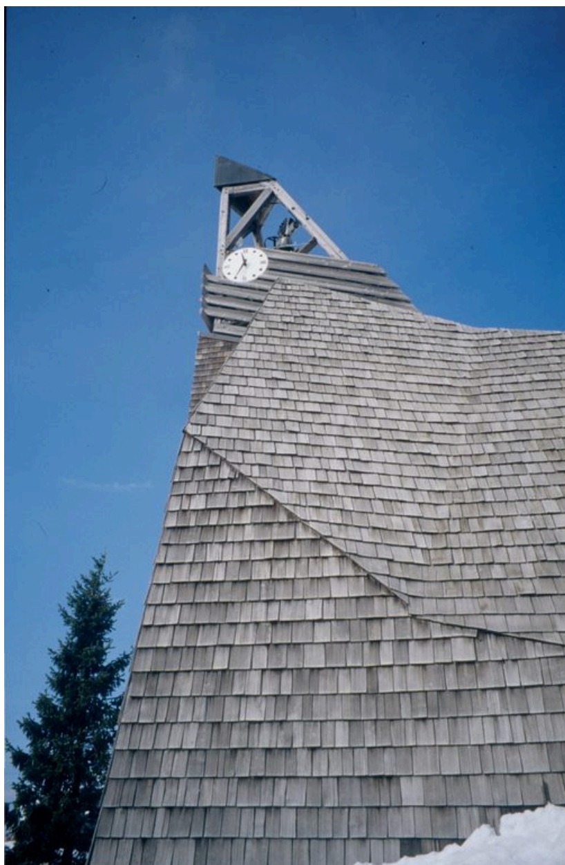
Détail du beffroi et de la couverture depuis le nord
