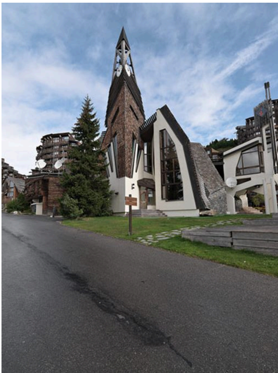
Vue d'ensemble du beffroi depuis le sud
