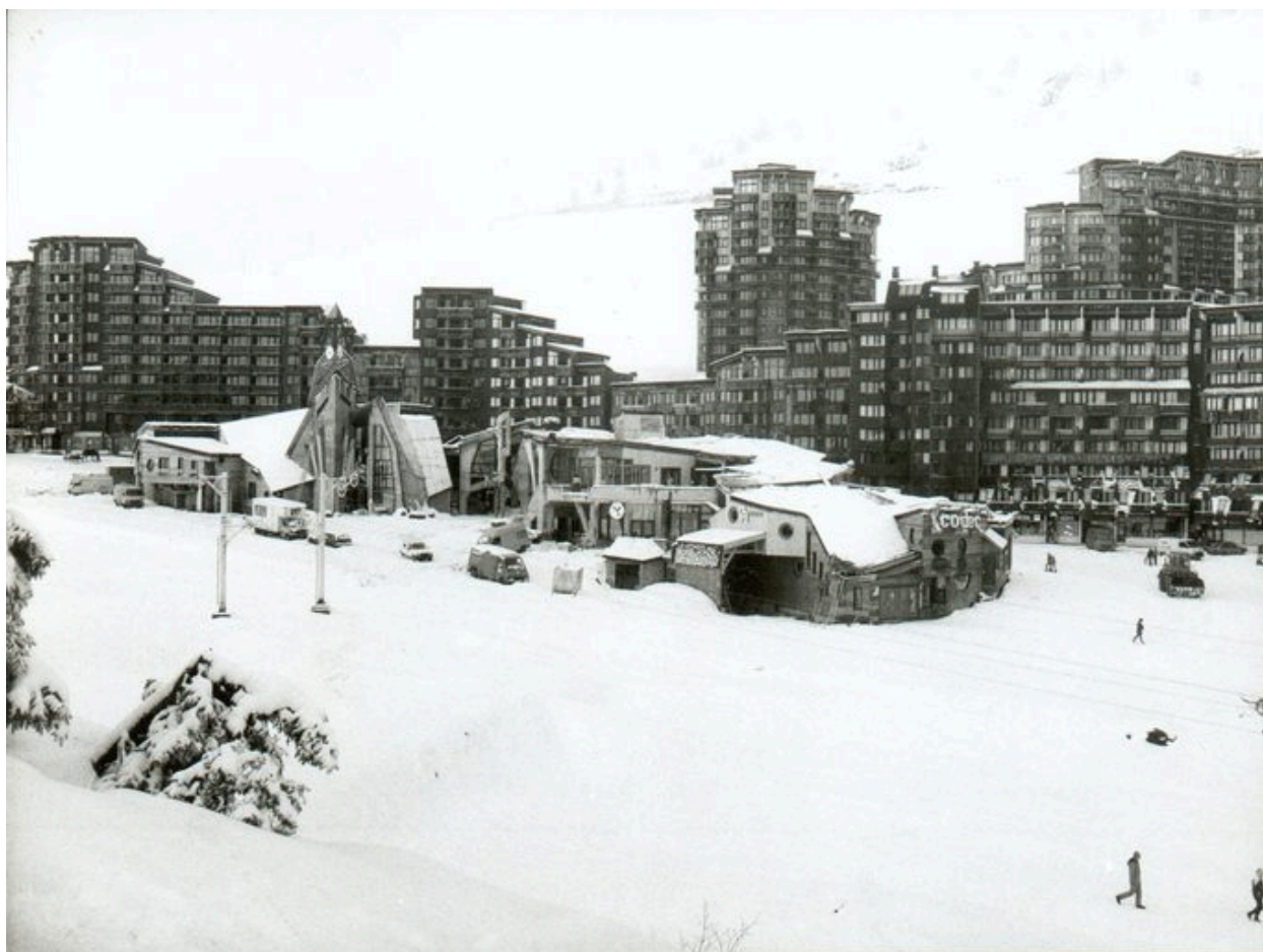
Vue du programme Place centrale en cours de construction. Photogr., 1984 (A. privées J. Labro)
