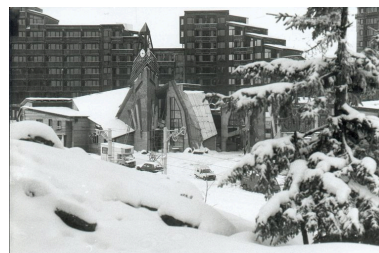
Vue du palais du festival en cours de construction. Photogr., 1984 (A. privées J. Labro) Phot. Jean-François Lyon- Caen, Phot. C. Salomon-Pelen IVR82_20087400493NUCB
