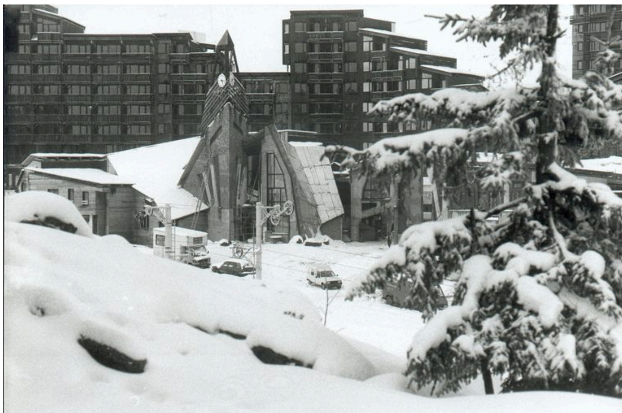
Vue du palais du festival en cours de construction. Photogr., 1984 (A. privées J. Labro)
