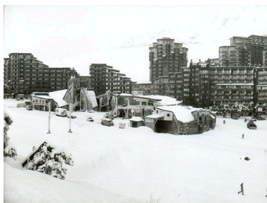
Vue du programme Place centrale en cours de construction. Photogr., 1984 (A. privées J. Labro) Phot. Jean-François Lyon- Caen, Phot. C. Salomon-Pelen IVR82_20087400492NUCB
