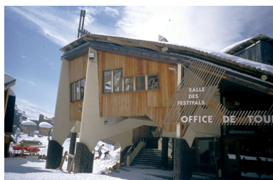
Vue de l'entrée Phot. Jean-François Lyon- Caen, Phot. C. Salomon-Pelen IVR82_20087400515NUCA
