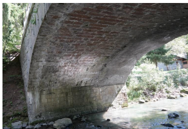
Pont de la Solitude, vue du dessous Phot. Pascale Renard IVR84_20207401037NUCA
