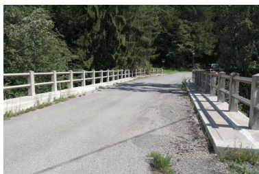
Pont de la Solitude, vue de la chaussée et des garde-corps Phot. Pascale Renard IVR84_20207401034NUCA
