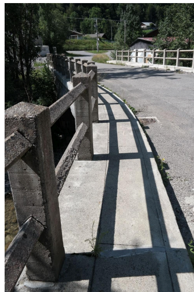
Pont de la Solitude, détail garde-corps et chaussée Phot. Pascale Renard IVR84_20207401038NUCA
