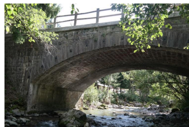
Pont de la Solitude, vue de la face aval Phot. Pascale Renard IVR84_20207401035NUCA
