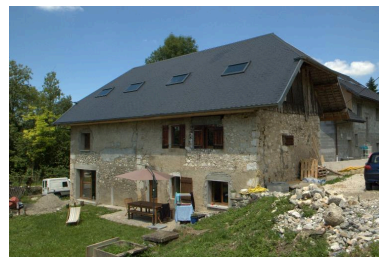
Les Nantets, Ferme, parcelle C3 852, vue d'ensemble. Phot. Thierry Monnet IVR84_20167302947NUCA
