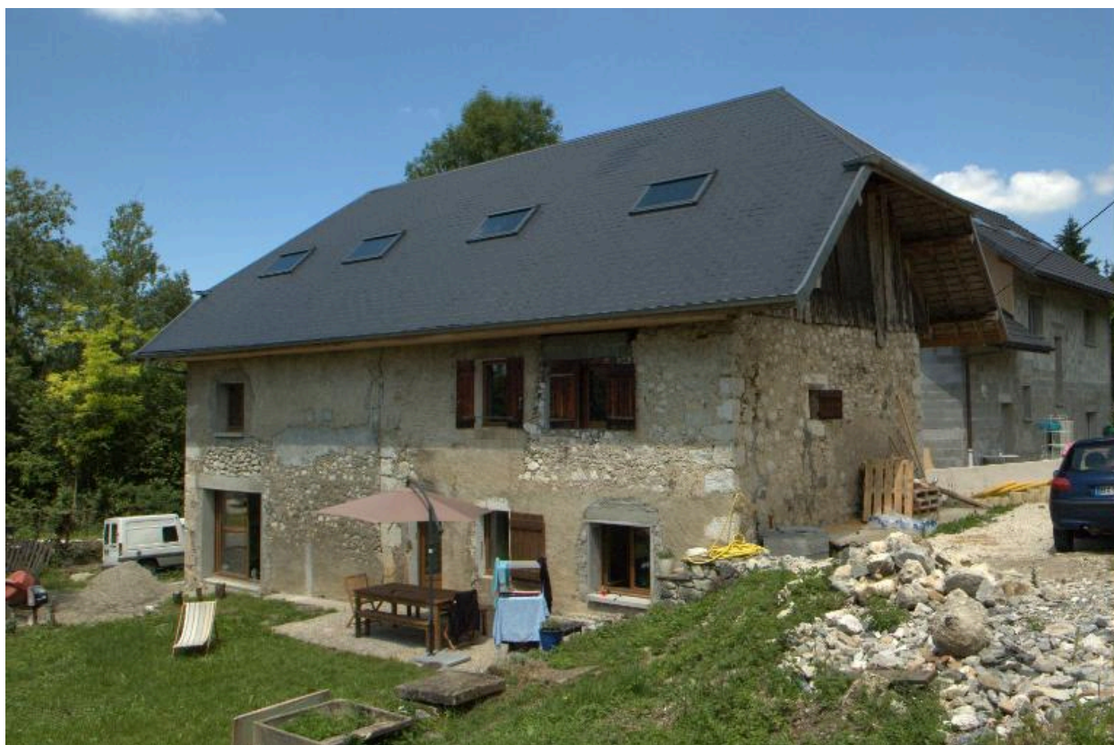
Les Nantets, Ferme, parcelle C3 852, vue d'ensemble.
