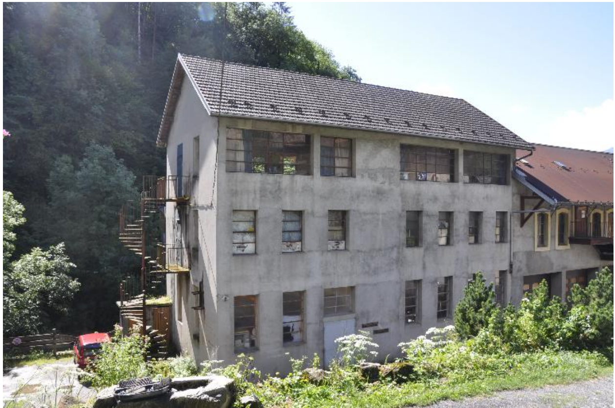
Extension de l'usine construite dans les années 1950
