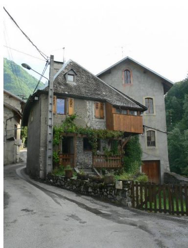
Vue de l'ancien bâtiment du pressoir à pomme en 2003 Phot. Joël SERRALONGUE IVR84_20167400240NUCA
