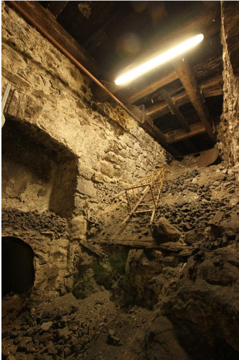
Massifs de l'ancienne turbine hydroélectrique démontée se trouvant au rez-de-chaussée
