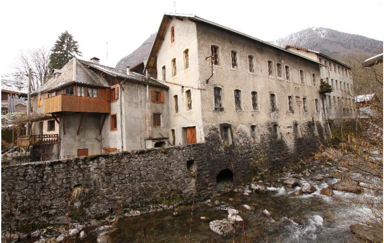
Vue des bâtiments de l'usine agrippés au quai longeant la rive droite du torrent du Foron
