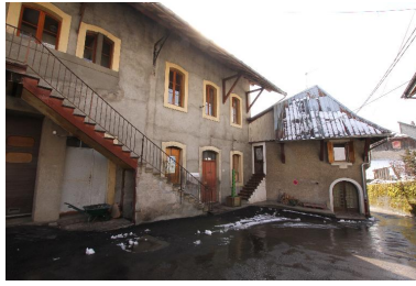
Depuis la cour intérieure, l'ancien bâtiment du pressoir est adossé au bâtiment de l'usine
