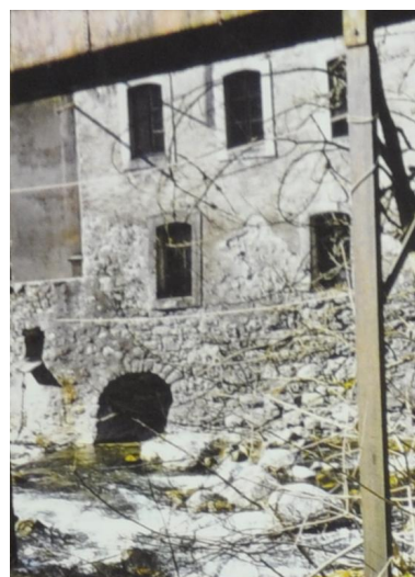
Canal de fuite de l'usine Phot. Juliette CHATEL IVR84_20167400239NUCA
