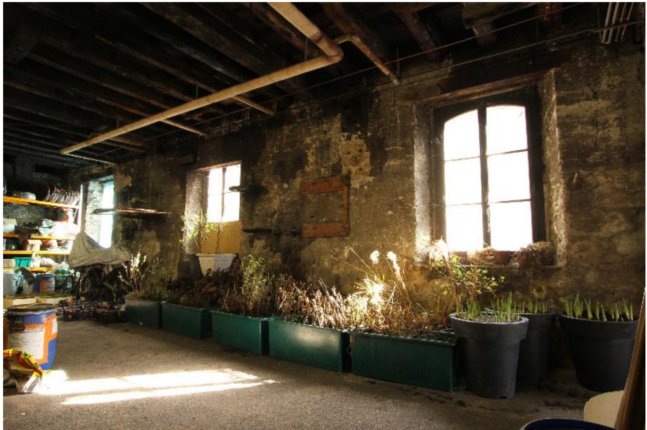
Vue des anciens ateliers du rez-de-chaussée transformés en pépinière
