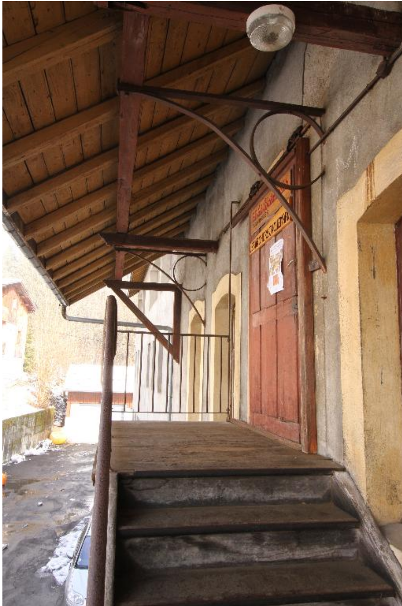
Vue de détail de la cursive animant la façade antérieure au nord ouest du bâtiment de l'usine
