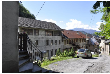
Vue de la cour intérieure prise depuis la voie communale du Vieux Pont Phot. Samir Mahfoudi IVR84_20167400243NUCA
