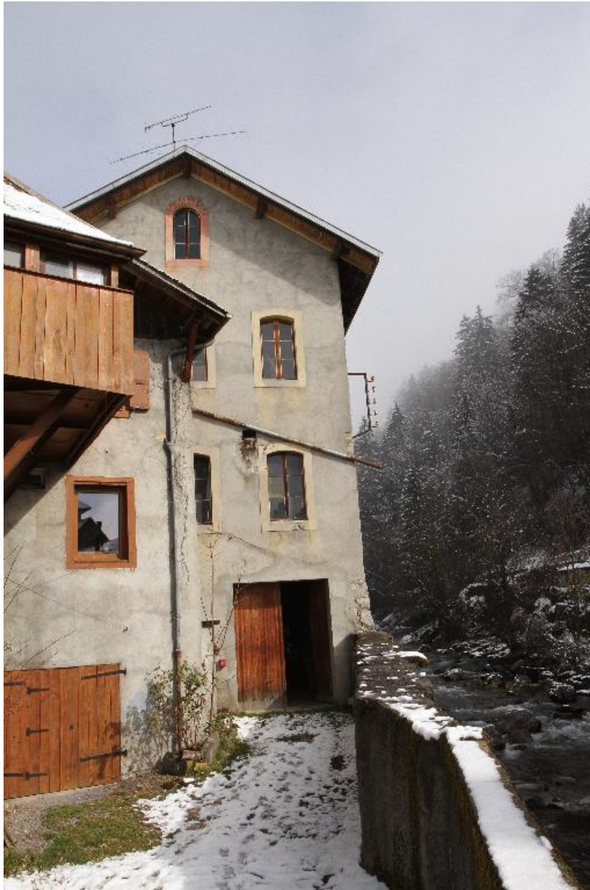
Entrée donnant sur la mur pignon sud-ouest du bâtiment de l'usine
