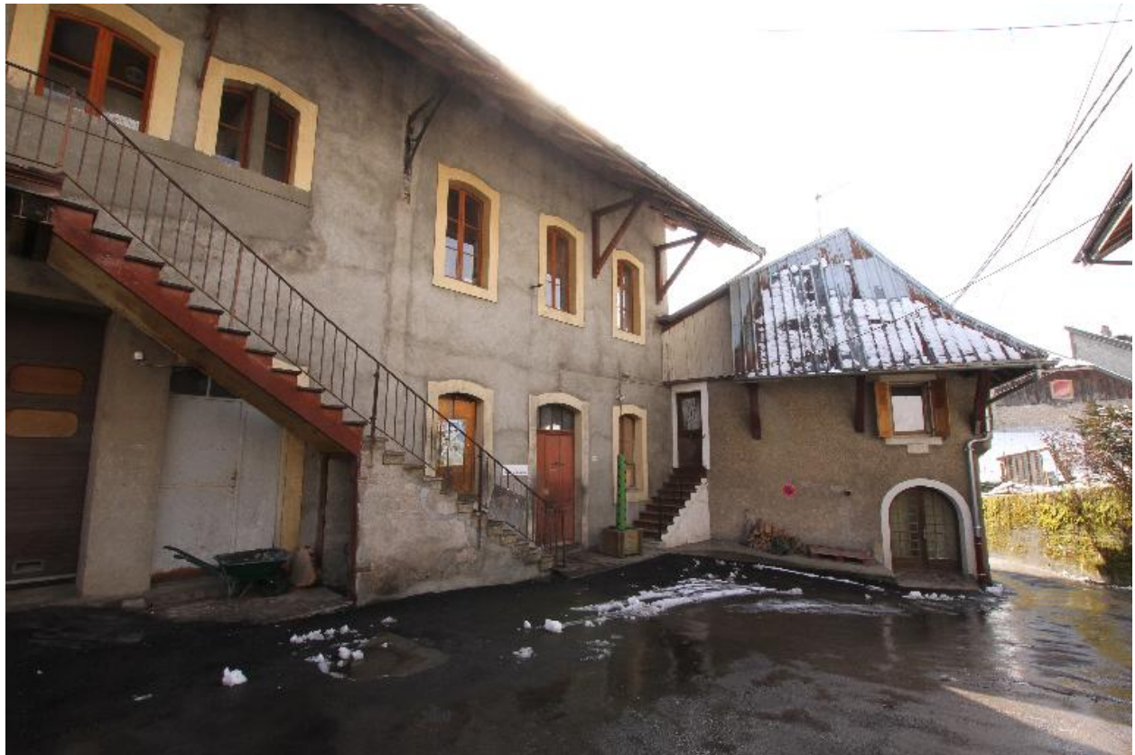
Depuis la cour intérieure, l'ancien bâtiment du pressoir est adossé au bâtiment de l'usine
