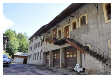
Vue des escaliers donnant sur la coursive de la façade antérieure du bâtiment de l'usine Phot. Samir Mahfoudi IVR84_20167400242NUCA
