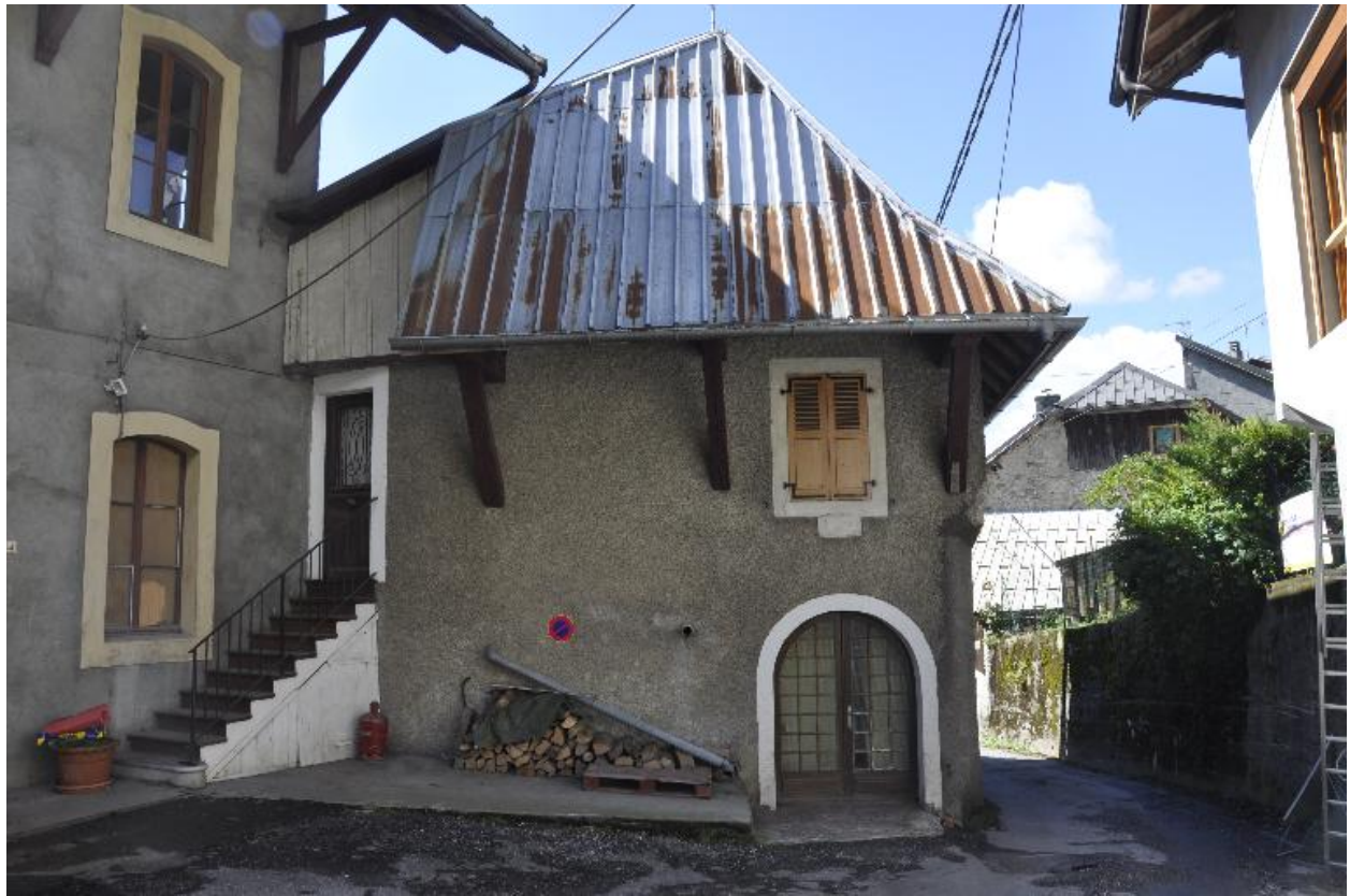
Vue du pressoir à pomme avec depuis la cour de l'usine
