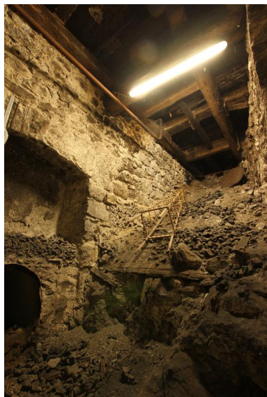
Massifs de l'ancienne turbine hydroélectrique démontée se trouvant au rez-de-chaussée Phot. Jocelyn Laidebeur IVR84_20167400246NUCA
